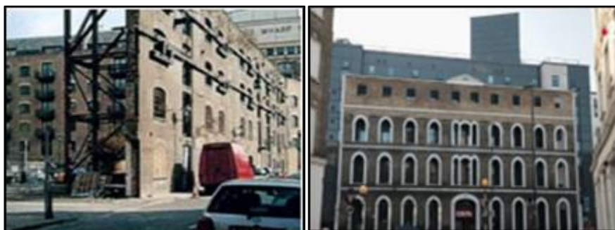
Figure 4.6. Immeuble de bureaux Docks de Londres en travaux et après l'intervention Source : https://www.aucame.fr/ ,2023
