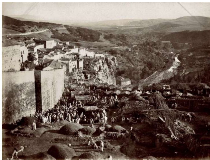
Figure 7- 3 : Accès de la ville du côté de Bab El Djebia et quartier des Béni ramasés.
