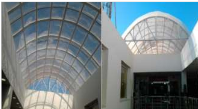
Figure 4.8. Toit rétractable en polycarbonate de l'atrium du centre commercial Sans Visa. Source : Fekkous (2017).
