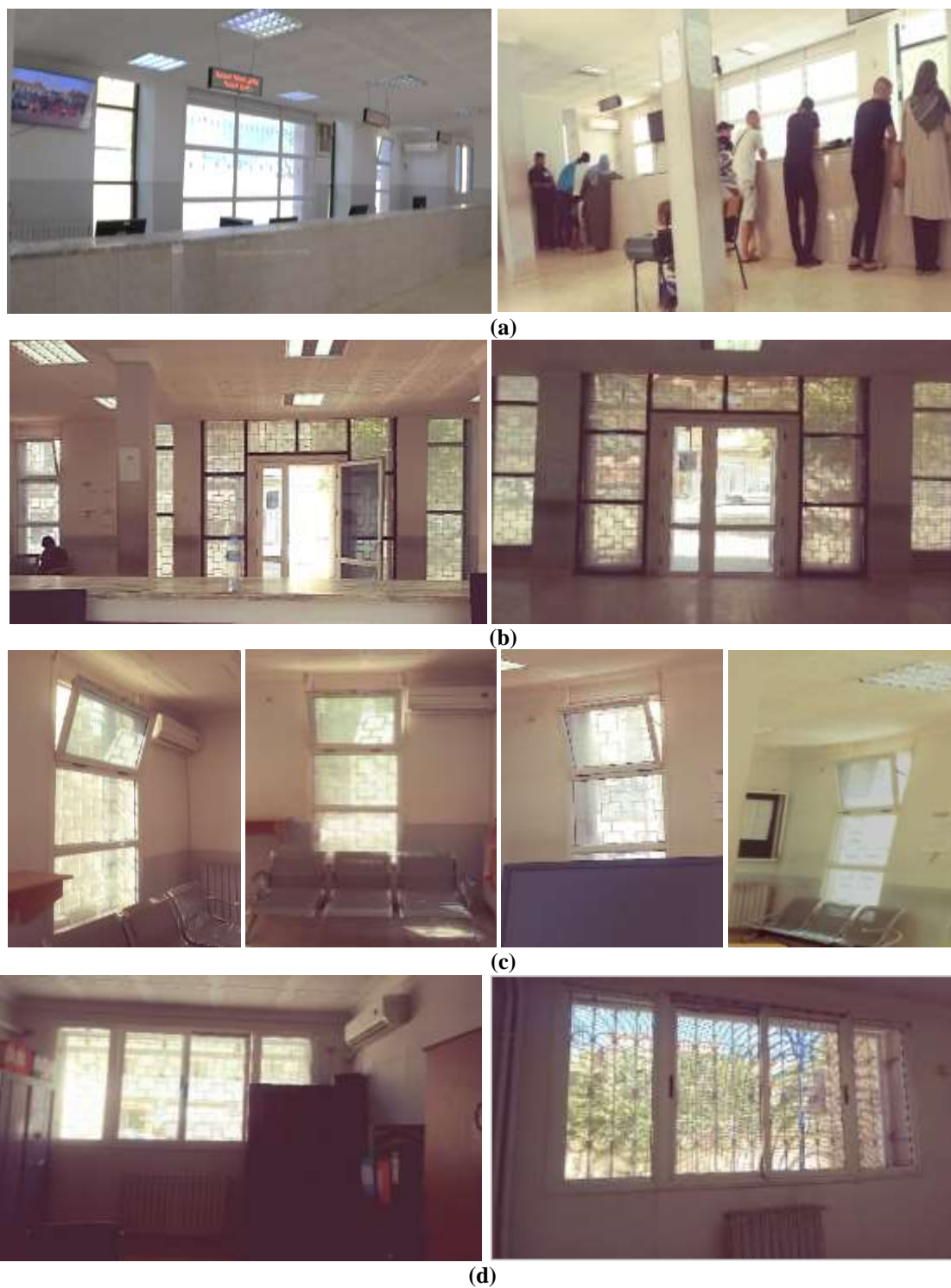
Figure 6.14. Fenestration de l'annexe : (a) : fenêtres d'espace guichet, (b): fenêtres du hall d'accueil, (c): ouverture maximale des fenêtres du hall d'accueil, (d) : fenêtre du bureau chef d'annexe. Source : Auteur (2022).
