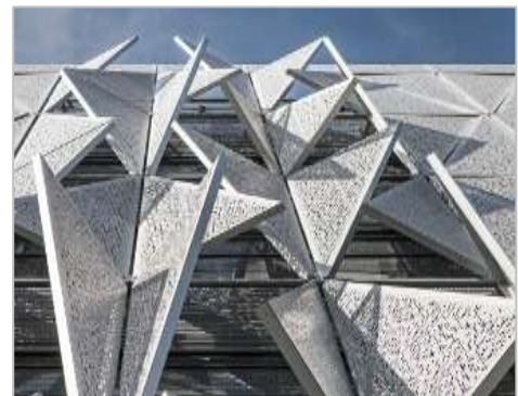
Figure 4.9. Façade de l'université Henning Larsen. Source : El-Dabaa (2016).
