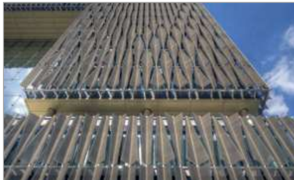
Figure 4.17. Bâtiment du siège social Q1. Source : Structurae (2022).
