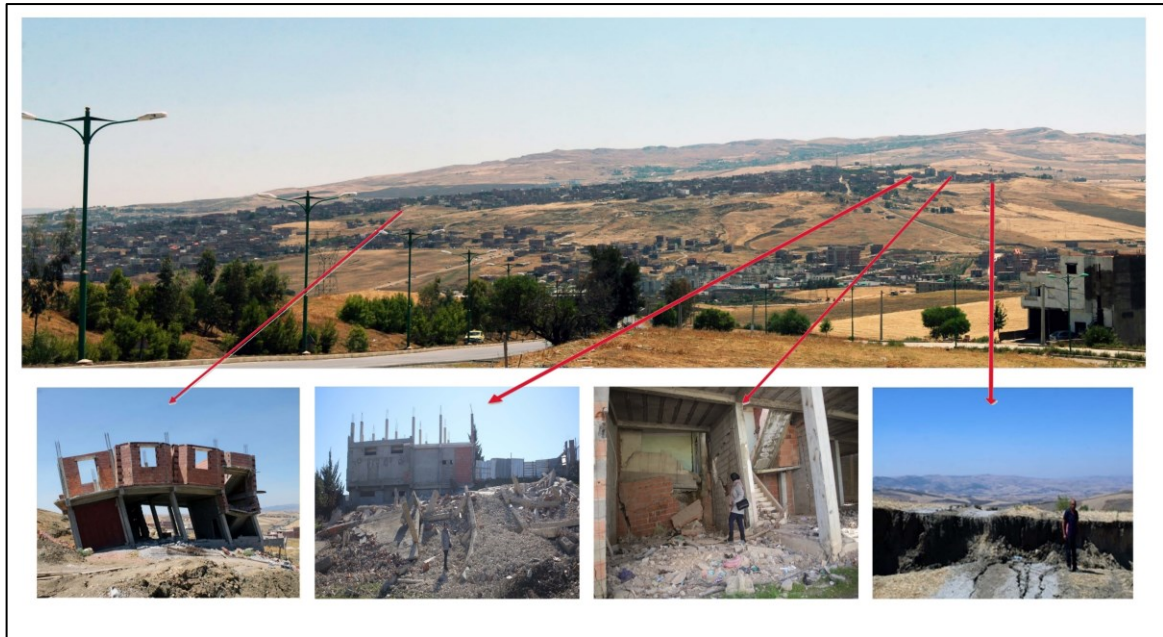
Figure.5.37 Vue d'ensemble et observations de terrain du glissement de terrain d'El Kherba (région de Mila) déclenché par le séisme de 2020, montrant la déformation du versant, des fissures au sol (décalage de 2,5 m) et des dommages structurels aux bâtiments.
