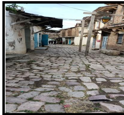
Figure 6.76. Vue sur une rue en moyen état
