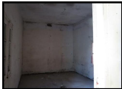
Figure 6.19. Vue sur une chambre (Bit)
