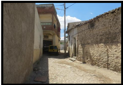
Figure 6.75. Vue sur une rue en bon état
