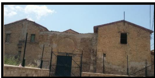
Figure 6.45. La façade principale de la mosquée
