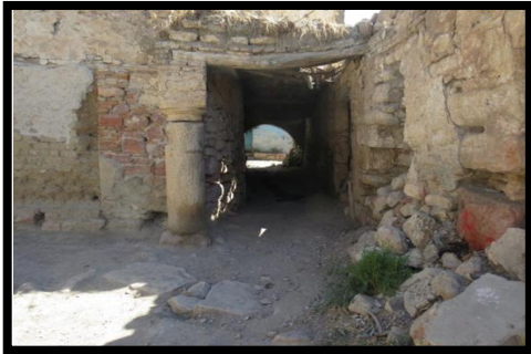
Figure 6.73. Vue sur une rue en moyen état
