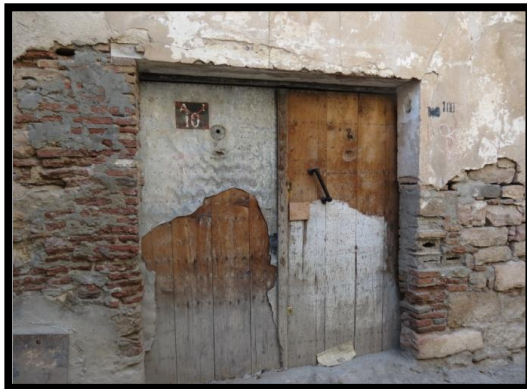
Figure 6.67. Vue sur une porte en bois massive sans arc
