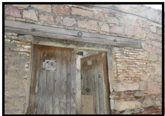
Figure 6.68. Vue sur une porte en bois massive sans arc
