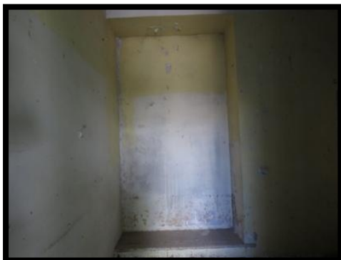
Figure 6.18. Vue sur une chambre (Bit)
