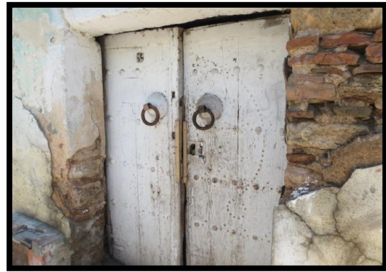
Figure 6.70. Vue sur une porte en bois massive sans arc
