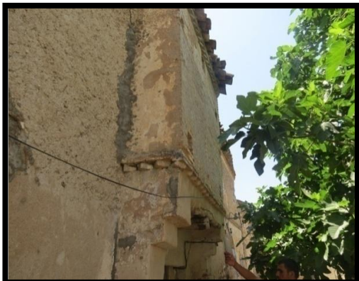
Figure 6.60. Vue sur un encorbellement (Type1)
