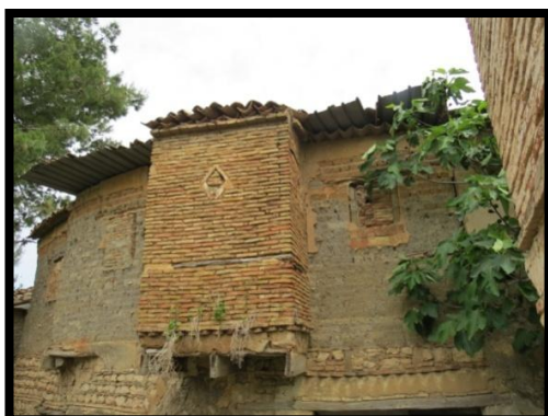
Figure 6.62. Vue sur un encorbellement (Type1)
