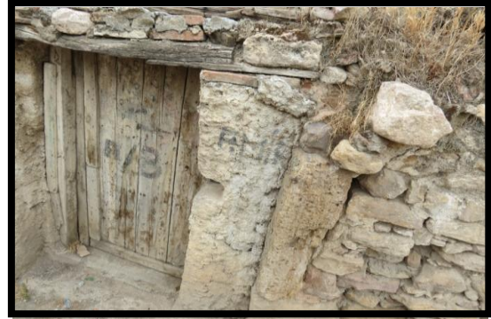
Figure 6.66. Vue sur une porte en bois massive sans arc
