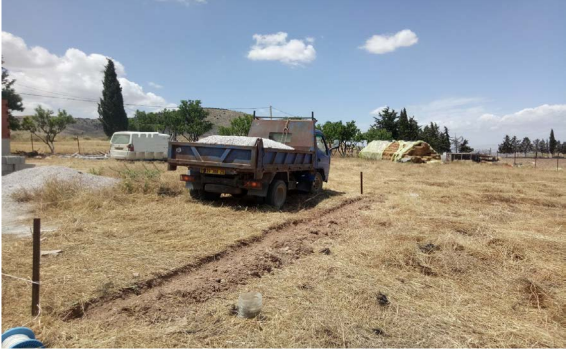
Figure 5. 2 : Construction des cellules expérimentales
