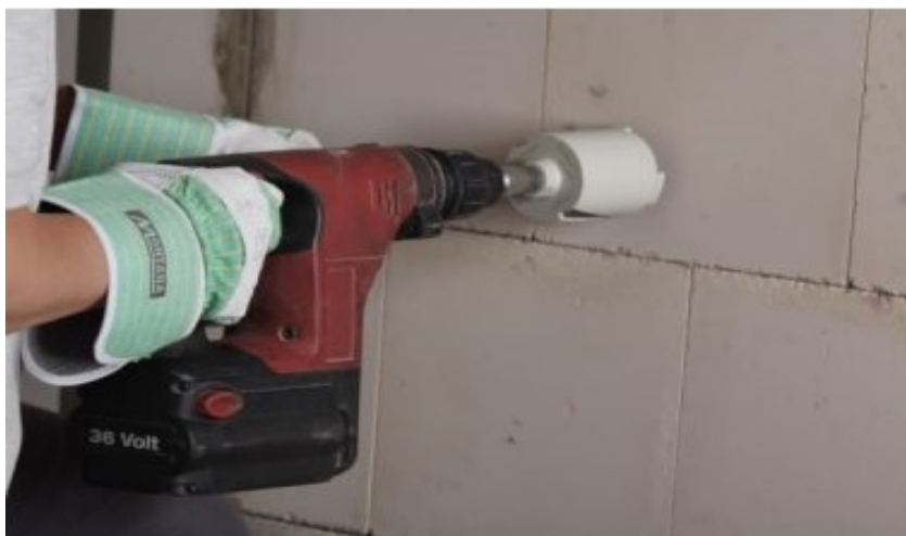
Figure 2. 18 : Exemple de prélèvement d'un échantillon de paroi (source : Éditée par l'auteur, 2020)
