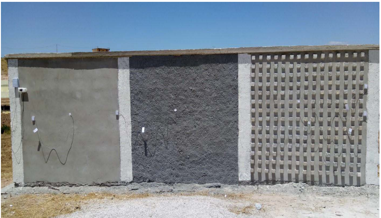
Figure 5. 21 : Installation extérieure des instruments de mesures
