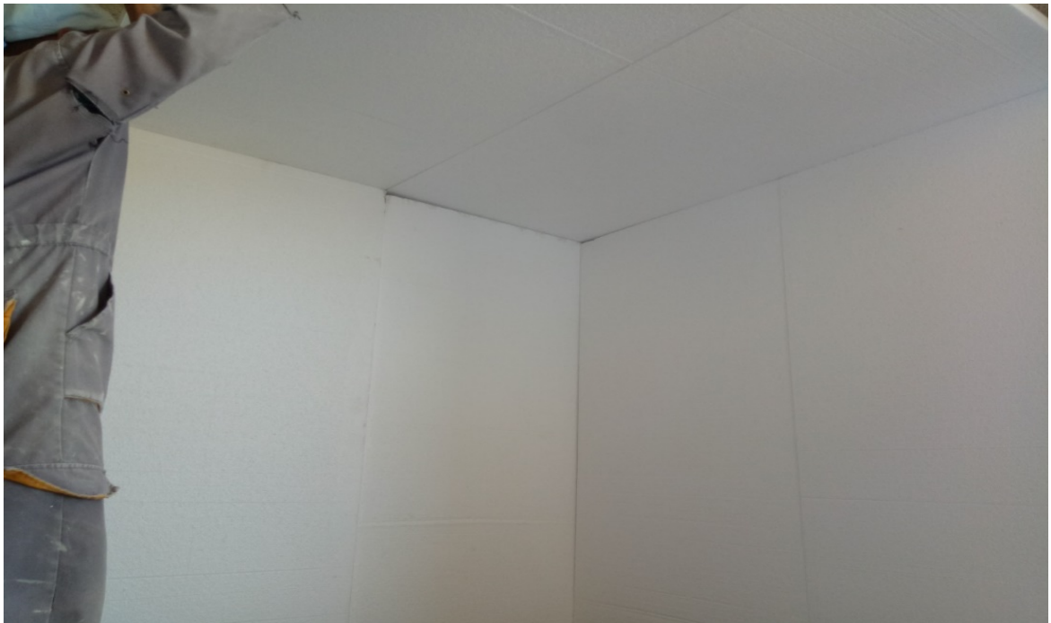
Figure 5. 10 : Mise en place d'isolation du toit de la salle tampon
