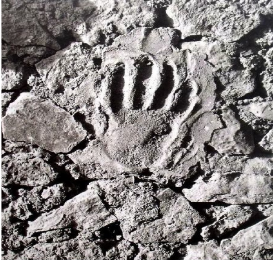
Figure 1. 15 : Application du revêtement à main nue afin de profiter de ces traces, à Ghardaïa (source : Raverau, 1981)
