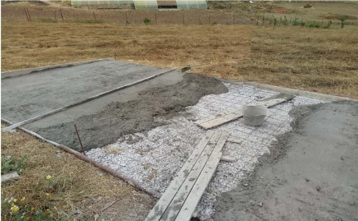
Figure 5. 4 : Pose et coulage de la plate-forme des cellules expérimentales
