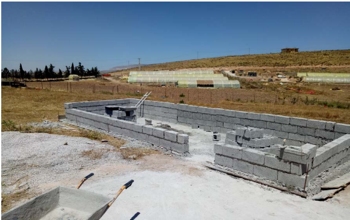
Figure 5. 5 : Travaux de maçonnerie de la salle tampon des cellules
