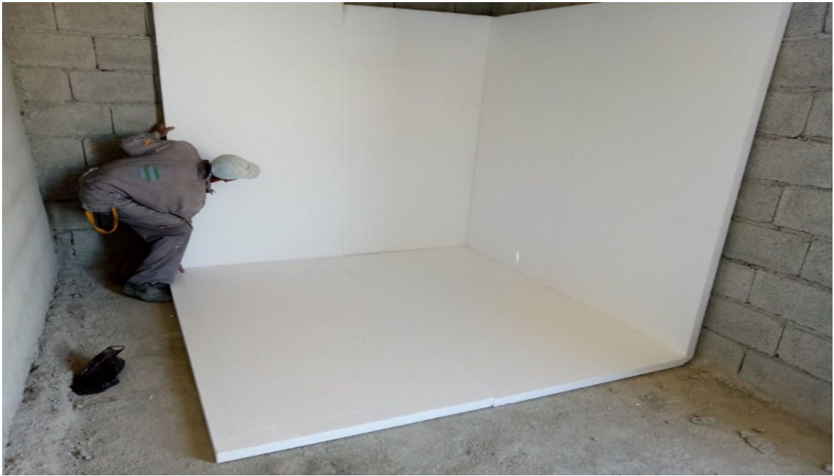
Figure 5. 9 : Mise en place de l'isolation de la salle tampon.
