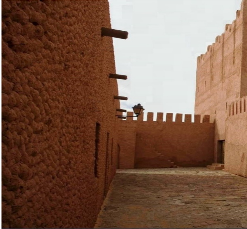
Figure 1. 16 : Application du revêtement extérieur par de petites boules en argile à Timimoun (source : Éditée par l’auteur, 2017)
