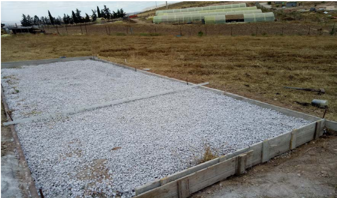
Figure 5. 3 : Construction du plancher des cellules expérimentales
