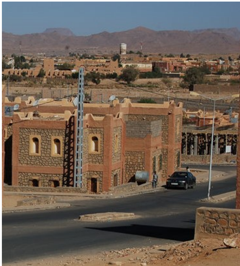
Figure 1. 12 : Revêtement extérieur sous forme de plaques de pierre naturelle.
