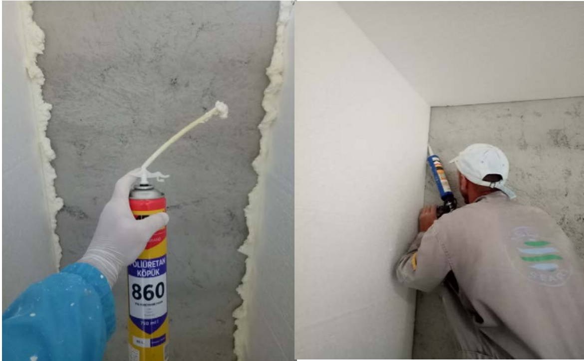
Figure 5. 11 : Séparation et isolation des cellules par des panneaux de polystyrène et confection des joints avec la mousse du Polyuréthane (source : Éditée par l’auteur, 2020).
