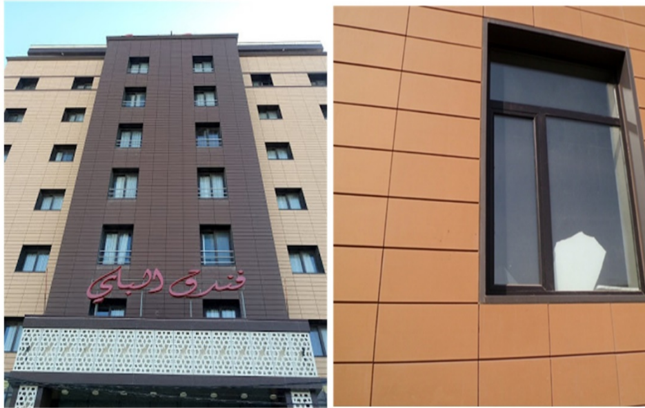
Figure 1. 4 : Exemple de revêtement ventilé en Algérie (source : Éditée par l'auteur, 2021)
