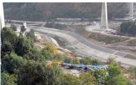
▼ Réaménagement paysagé des berges de Oued Rhumel ( travaux en cours de réalisation 2017)
