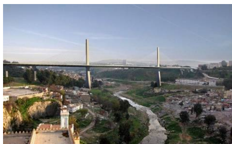
▼ Viaduc Saleh Bey((2010-2014): renforcer l'image de la ville des ponts.
