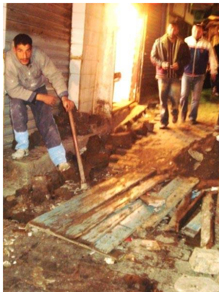
Travaux de réhabilitation de la rue Mellah Slimane (Souika) en cours de réalisation - en 2006 - photos: www.constantine-hier-aujourd'hui.fr
