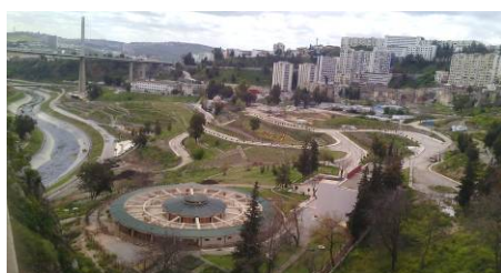
▼ Aménagement d'un parc urbain à Bardo( travaux en cours de réalisation 2017): un poumons au cœur de la ville, une image à valorisée...
