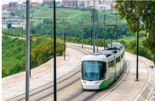
Figure 8.120 : La ligne du tramway à l'intérieur de l'université Mentouri. (Source : Auteur, 2019)
