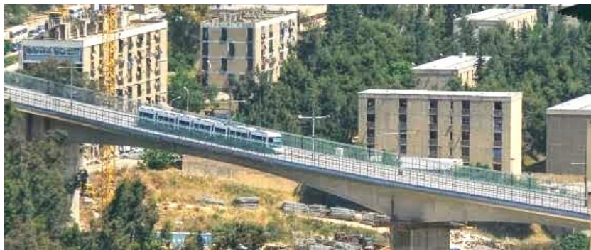
Figure 8.118 : Le viaduc du tramway. (Source :www.rifecq.com)
