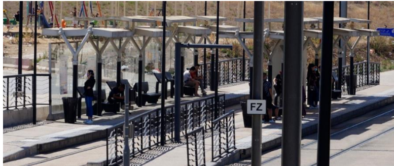
Figure 7.96 : Équipement de la station du tramway de Constantine (station Kheznadar). (Source : Auteur, 2020)
