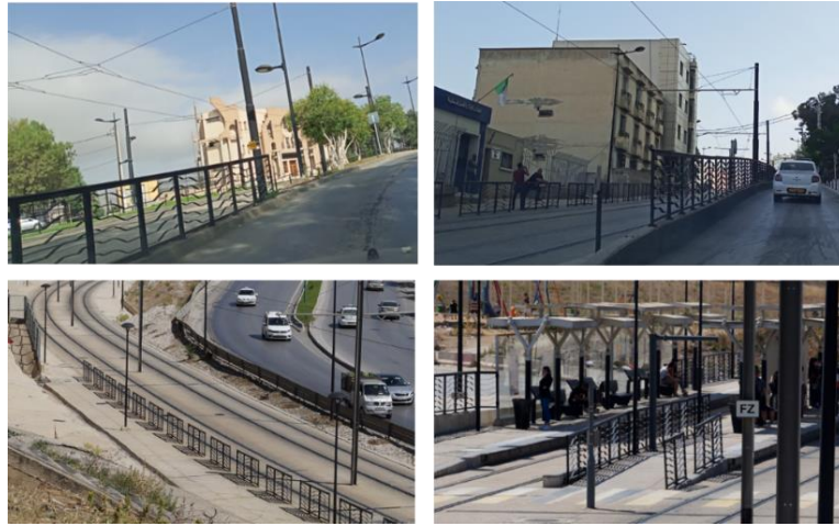
Figure 8.123 : Les barrières de protection. (Source : Auteur, 2019)
