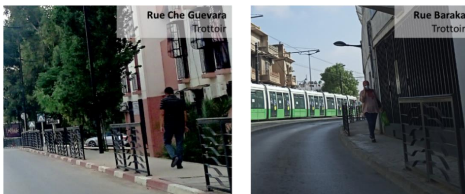
Figure 8.116 : Les trottoirs. (Source : Auteur, 2019)
