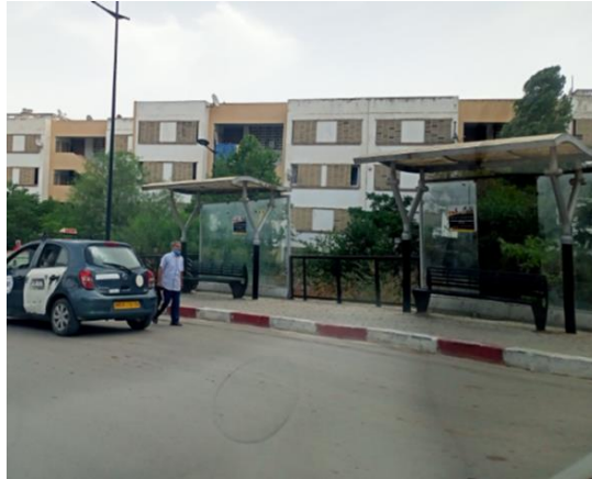
Figure 8.126 : Abris de bus - rue Che Guevara-. (Source : Auteur, 2019)
