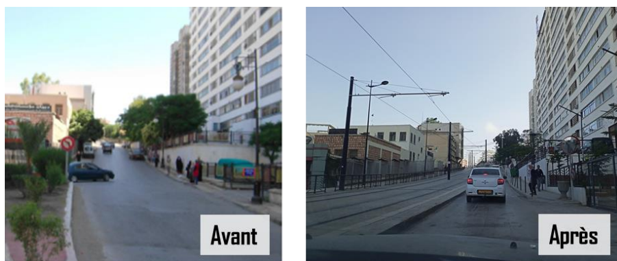
Figure 8.110 : L'insertion latérale au niveau de la rue Baraka avant et après l'insertion du tramway. (Source : Auteur 2018, (KAGHOUCHE, 2010))
