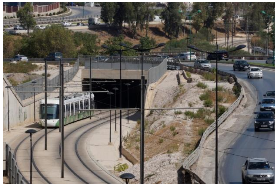
Figure 8.121 : Vue sur la sortie du tunnel -RN79-. Source : Auteur, 2019
