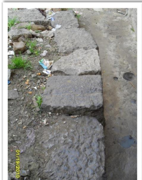
Figure 18 : Soubassements de constructions indéterminées Source : Photos P.P.S.M.V.S.S Constantine, 2010.
