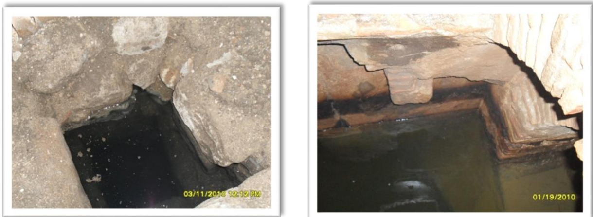
Figure 21 : Citernes souterraines Source : Photos PPSMVSS Constantine, 2010.
