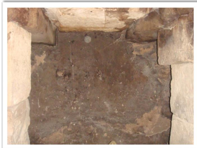
Figure 16 : Structure d'une maison Source : Photos P.P.S.M.V.S.S Constantine, 2010.
