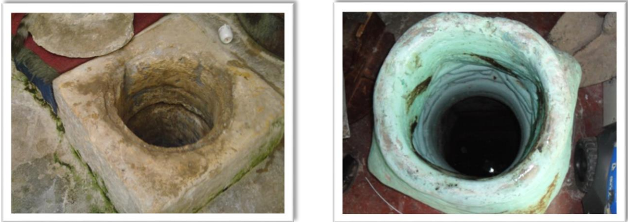
Figure 20 : Puits ou madjen Source : Photos PPSMVSS Constantine, 2010.
