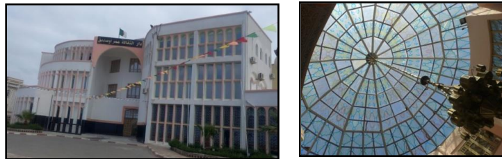
Figure IV.2 : Vues sur la maison de la culture
