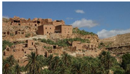
Figure 8.31 maisons à Ghoufi, Algérie, source : https://commons.wikimedia.org/wiki/File:Maisons_de_Ghoufi,_Wilaya_de_Batna_2.JPG
