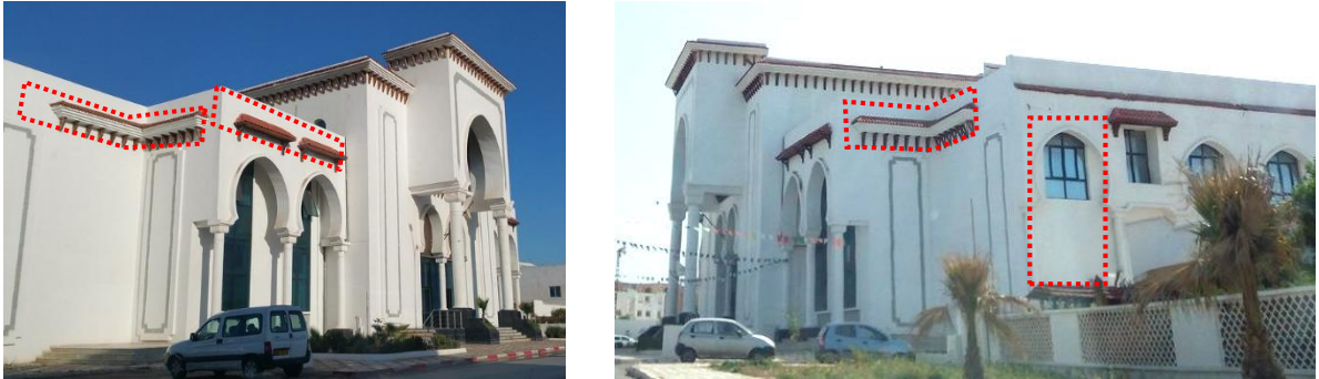
Figure 3.43 Façades latérales de l'école régionale des beaux-arts, Source : https://www.skyscrapercity.com/showthread.php?t=1227023
