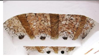
Figure 3.65 plancher en palmier et pierres.
