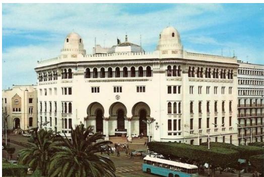
Figure 3.28 Grande poste d'Alger, Source : www.delcampe.net/cartes-postales/algerie .
