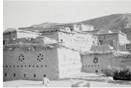
Figure 8.29 maisons du village chaoui de Menaâ, Algérie Décembre 1936, source : https://mydearalgeria.tumblr.com/post/
