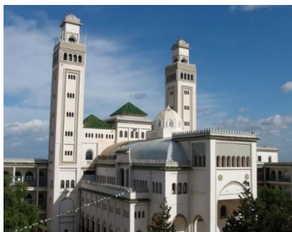
Figure 3.34 Institut des sciences islamiques Alger, par Bouchama, source : www.sites.google.com/site/lamkadem5/1er-architecte
