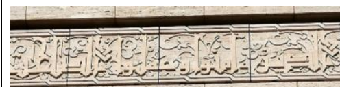
Figure 5.136 Détail de la calligraphie sur la façade de la mosquée d'Alger, source www.skyscrapercity.com/ , mai 2020.
