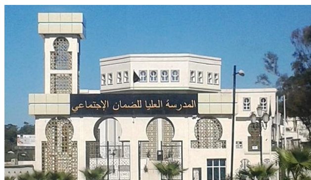
Figure 3.38 Façade extérieure de l'Ecole supérieure de la sécurité sociale, Source : https://www.craag.dz/cmga7/plan-acces.html .
