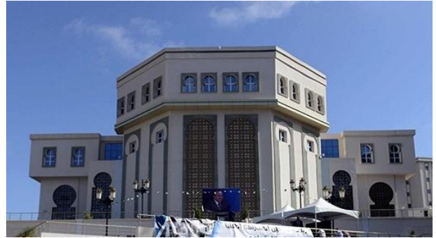
Figure 3.39 Façade intérieure de l'ESSS Source : http://www.premier-ministre.gov.dz/ar/premier-ministre/
