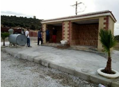
Photo 21: réhabilitation d'un arrêt de bus. Tirée de la page du groupe Oued Taga- اغزر نثاڤا
