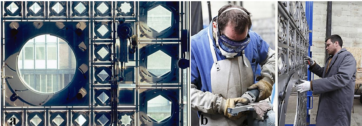
Fig.III.9 (a) mécanisme des moucharabiehs de l'institut du monde arabe (Source: www.akdn.org ), (b) rénovations des moucharabiehs en 2017 (Source: www.imarabe.org )
