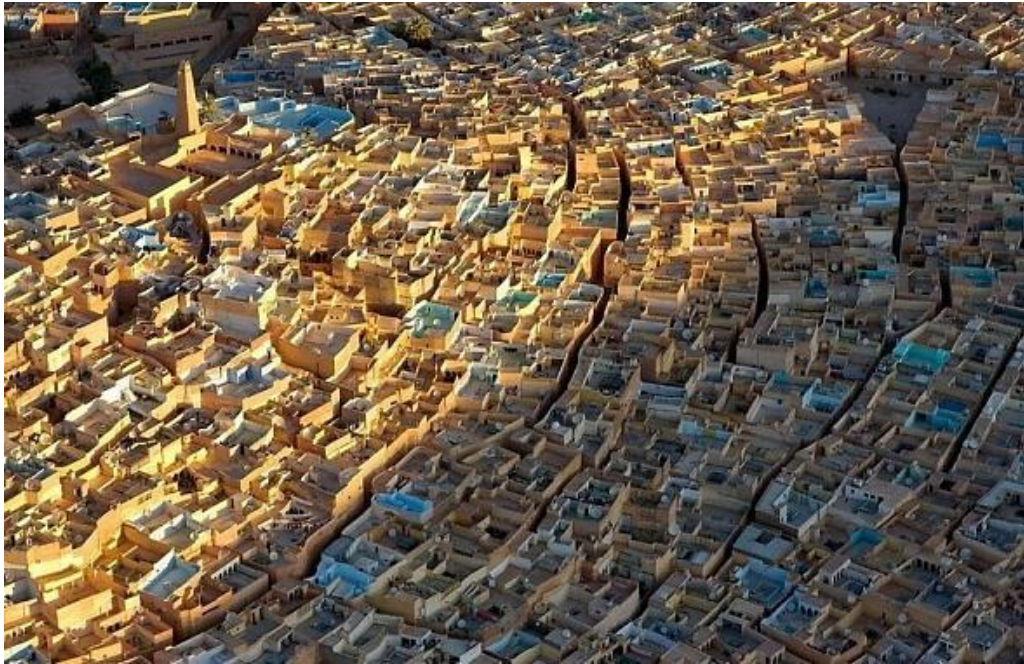
Fig.III.1 Ghardaïa, vallée du M'zab, au sud algérien : tissu compact, toitures plates, constructions massives avec petites ouvertures vers l'extérieur et couleurs claires qui est celle de la chaux utilisé communément pour les revêtements des murs et les Terraces
