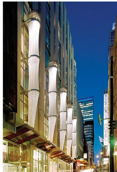
Fig.II.24 Système de rafraîchissement «tours de douche » du bâtiment CH2 (Source: www.mickpearce.com)
