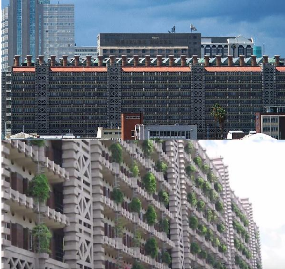
Fig.II.21 Façade extérieure d'Eastgate Building avec les auvents massifs
