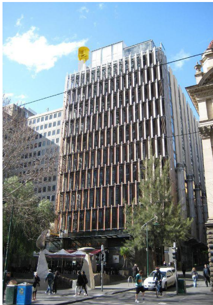
Fig.II.22 Vue sur la façade ouest du bâtiment CH2 avec les volets automatiques en bois
