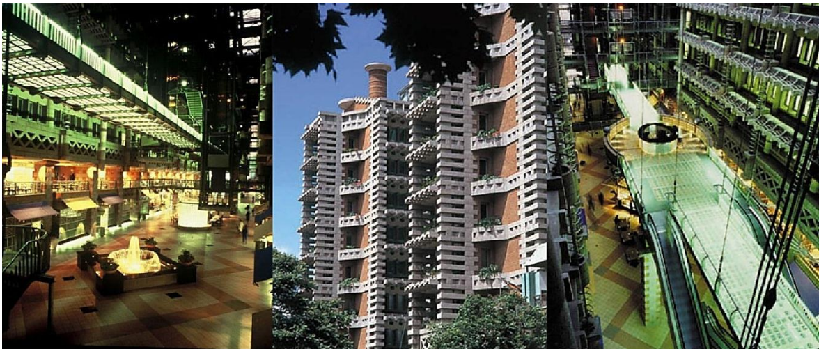
Fig.II.18 Différentes vues du bâtiment Eastgate Building à Harare
