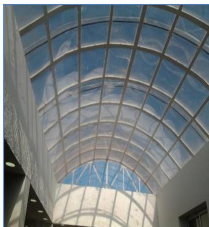
*Figure IV.5. Toit d'atrium sous forme d'un berceau.
