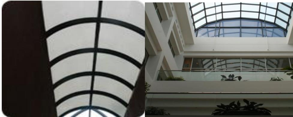
**Figure I.26.** Puit de lumière sous forme d'un berceau.
