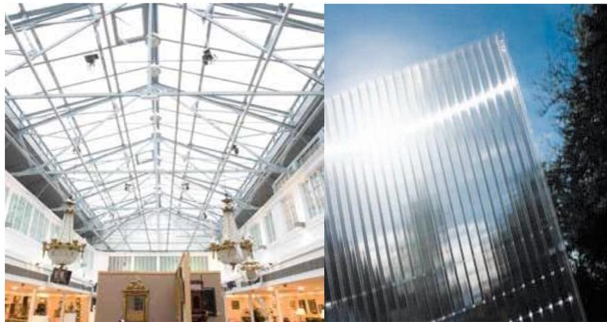
**Figure III.8.** Vitrage en polycarbonate alvéolaire.
