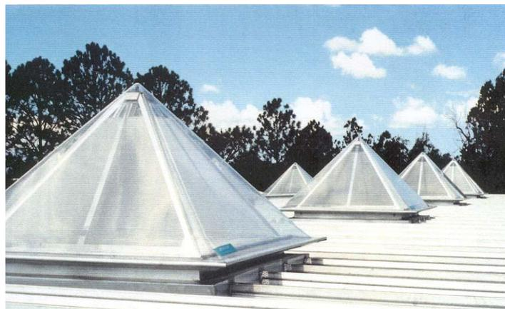
**Figure I.36. Lucarne avec LCP sélectifs angulaires**
