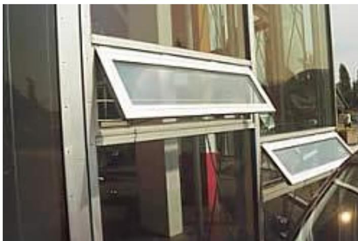
**Figure II.9.** Ouvertures inférieures.
