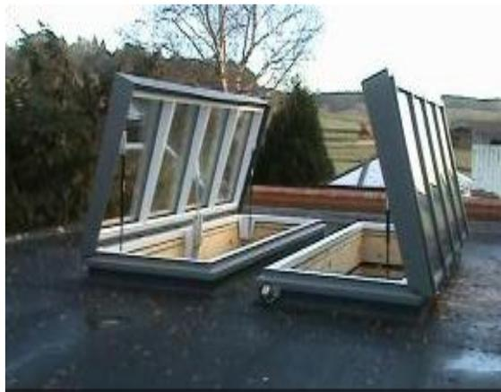
**Figure I.32.** Skylight qui s'ouvre manuellement
