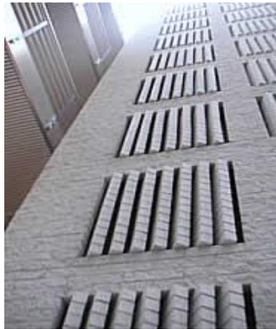
*Figure I.12. Exemple d'absorbeurs acoustiques intégrés sur les parois d'un atrium.
