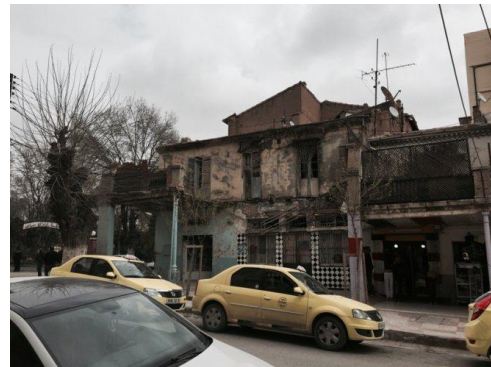
Figure 56 Immeuble en mauvais état et les propriétés sont complètement abandonnées
