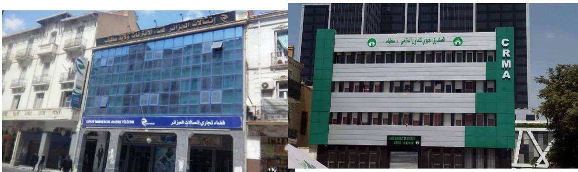
Figure 62 L'introduction de nouveaux matériaux (Façade alucobonde, façade en verre), Boulevard 8 mai 45 (Source : Auteur)
