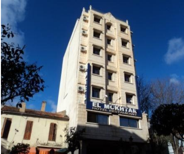
Figure 61 Hôtel en R+6 (état après la reconstruction) à coté de maison en RDC+1 avec tuile (Avenue 8 mai 42) (Source : Auteur)
