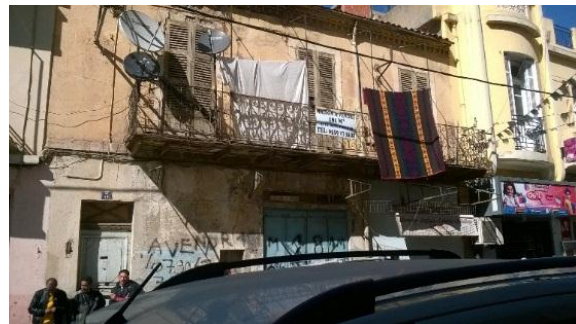
Figure 56 Logement en moyen état mis en vente et les propriétés sont occupées (Rue
