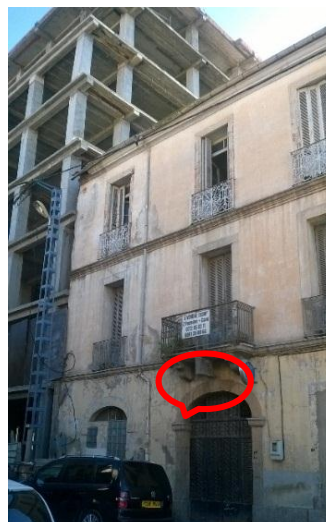
Figure 49 Immeuble vacant une entrée d'immeuble complètement murée à l'aide de parpaings.
