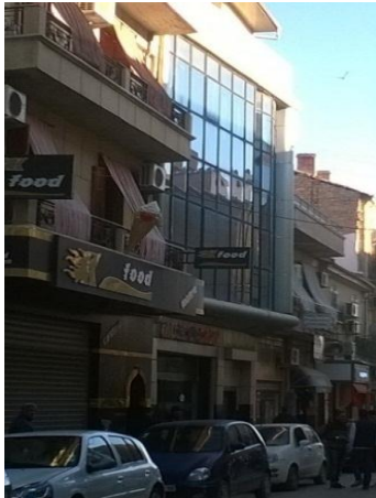
Figure 41 : une ancienne bâtisse reconvertie en superette après démolition (Source : Auteur)
