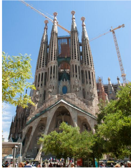
Figure 3 L'œuvre inachevée représentée plastiquement par le chantier sans fin de la Sagrada Família de Barcelone.
