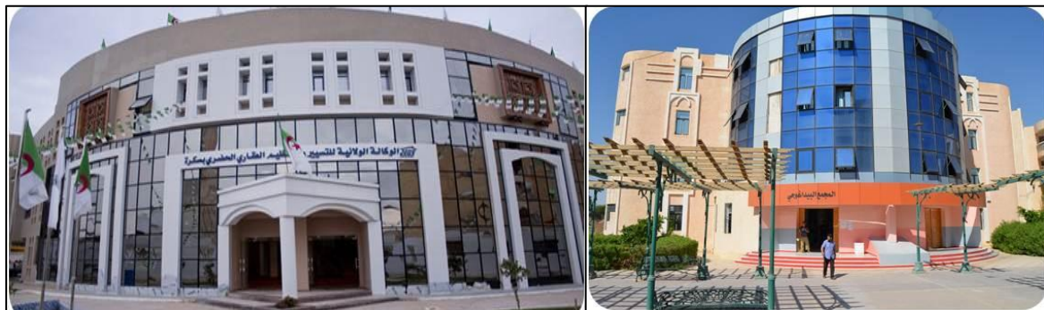
Fig.IV.5 : Bâtiments administratifs à la ville de Biskra (Source : Auteur, 2017)
