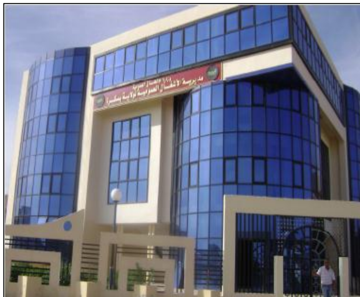
Fig.IV.7: Vue sur la façade sud du cas d'étude
