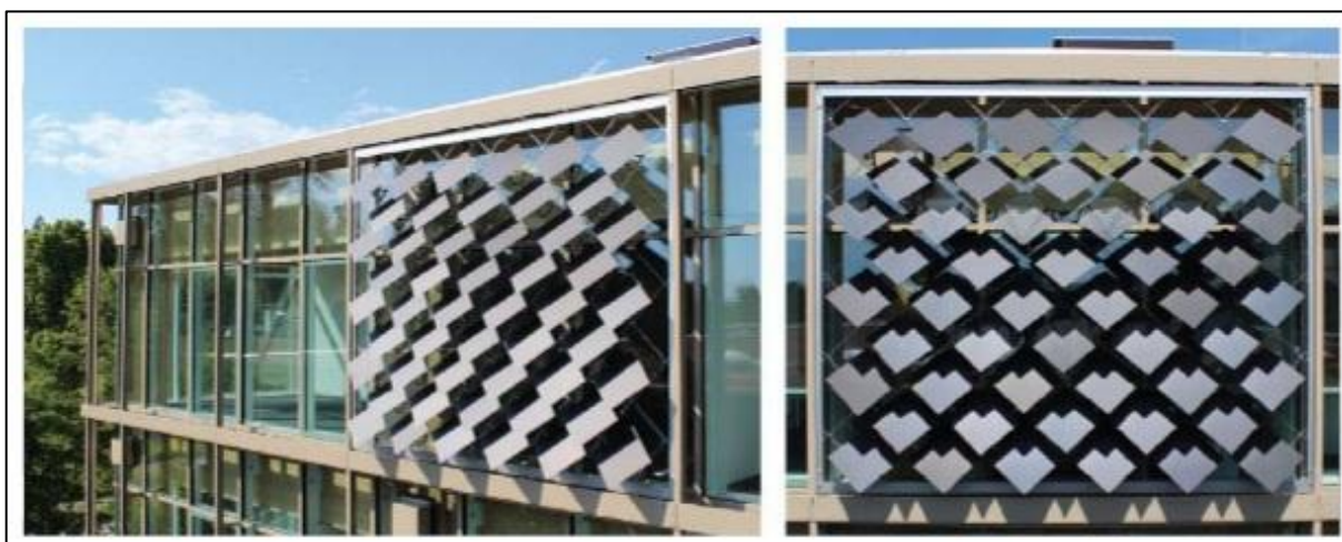
Fig.III.12 : Un système d'ombrage dynamique avec des modules PV intégrés
