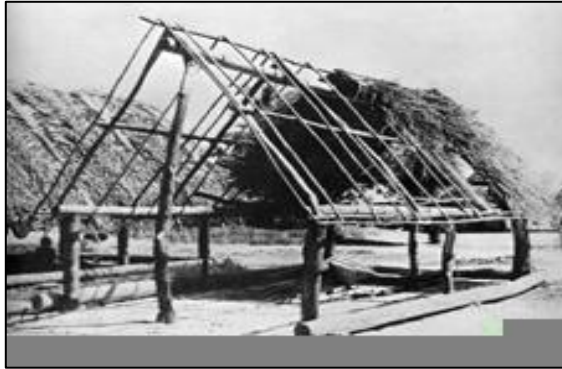
Fig.I.1 : Abri primitif à ossature de bois et un toit de chaume, les îles Salomon
