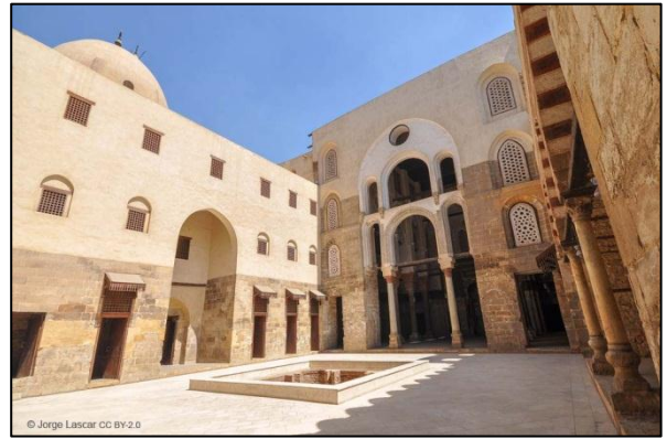
Fig.I.10 : Façade du complexe Qalawun — Égypte
