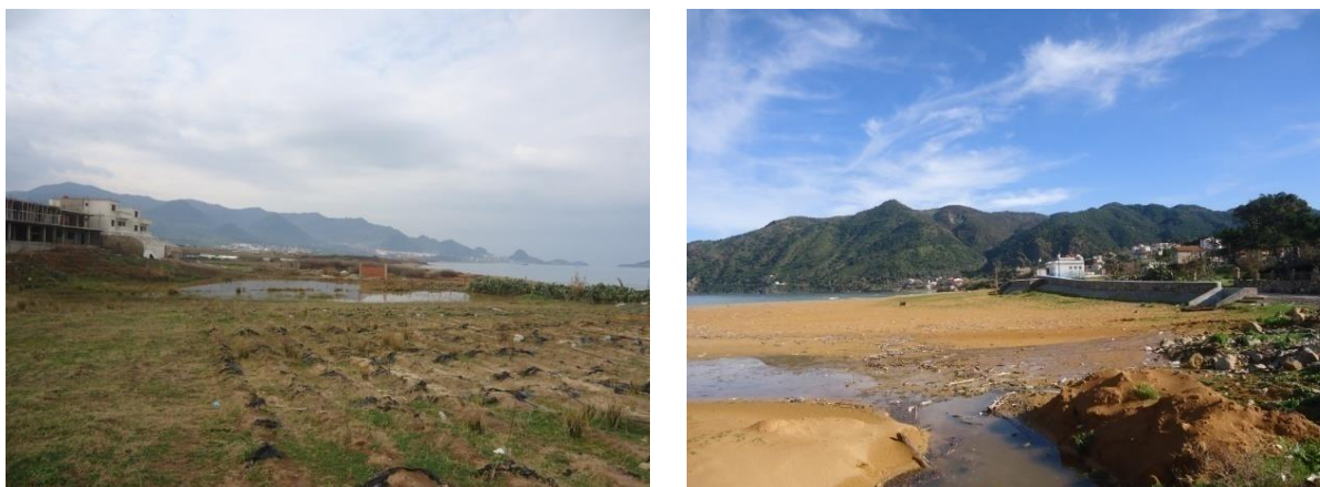
Figure 0.3 : El Aouana, constructions empiétant sur les terrains agricoles et la bande littorale non constructible du côté du Rocher Noir (à gauche) et rejet d'eaux usées, à ciel ouvert, au niveau de la plage des Aftis (à droite).
