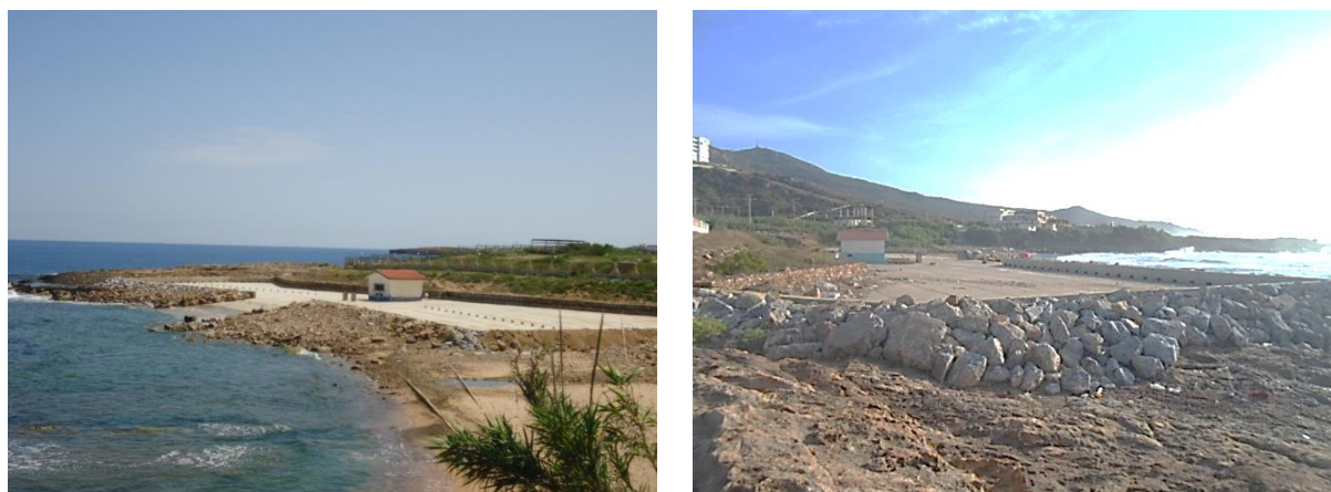
Figure 1.12 : Vues avant et après achèvement des travaux d'engrochement : la plage d'échouage de Jijel (Ouled Bounar), un projet boudé par ses usagers.
