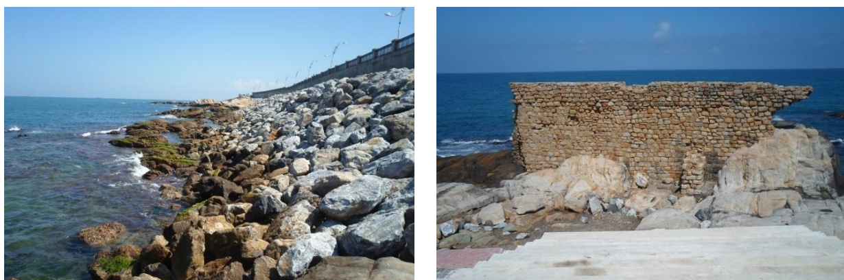
Figure 7.10 : Réaménagement du front de mer « Bordj Echetti » à Jijel : entre enrochement et bétonnage.
