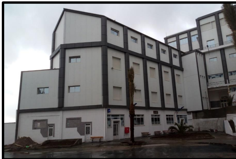
Photo -III-1- : Façade extérieure du bloc de l'investigation (Source Auteur).
