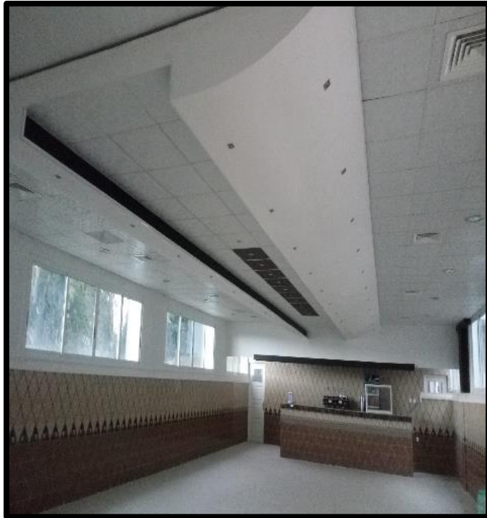
Photo-III-2- Vue intérieure de l'échantillon mesuré du Foyer ( Source Auteur ).
