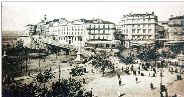
Fig. n°7 : Vue sur la place de la brèche (période coloniale)
