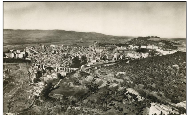
Fig. n° 26: Vue aérienne du pont Sidi Rached 1959
