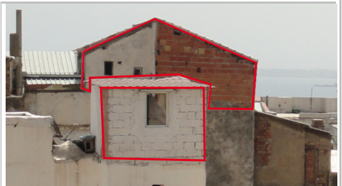
Photo 59 :Rajout illustrant l'appropriation de la terrasse par la construction d'une pièce en brique creuse.
