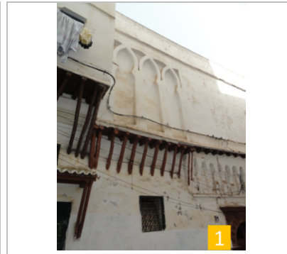
Photo 60 : Permanence des éléments de décor, nouveau revêtement de la façade.
