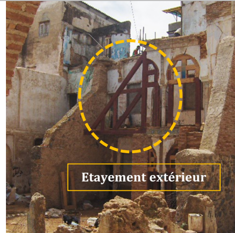
Photo 39 : Travaux d'étayement de la bâtisse n° 21 Rue Djouab Mutapha avant et après
