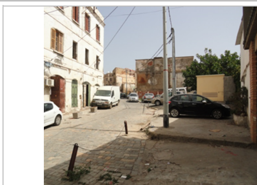
Photo 80 : Appropriation des parcelles (en aire de stationnement) issues de l'effondrement des bâtisses
