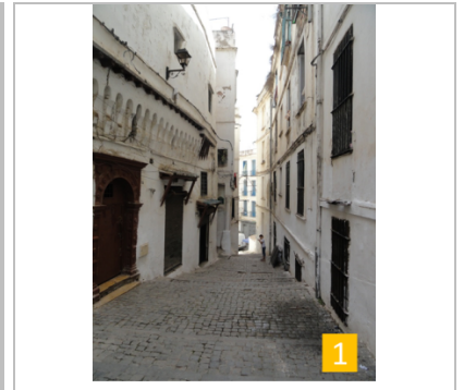
Photo 61 : Echoppes fermées et pavage dégradé (rue sidi Driss Hamidouche 2013).
