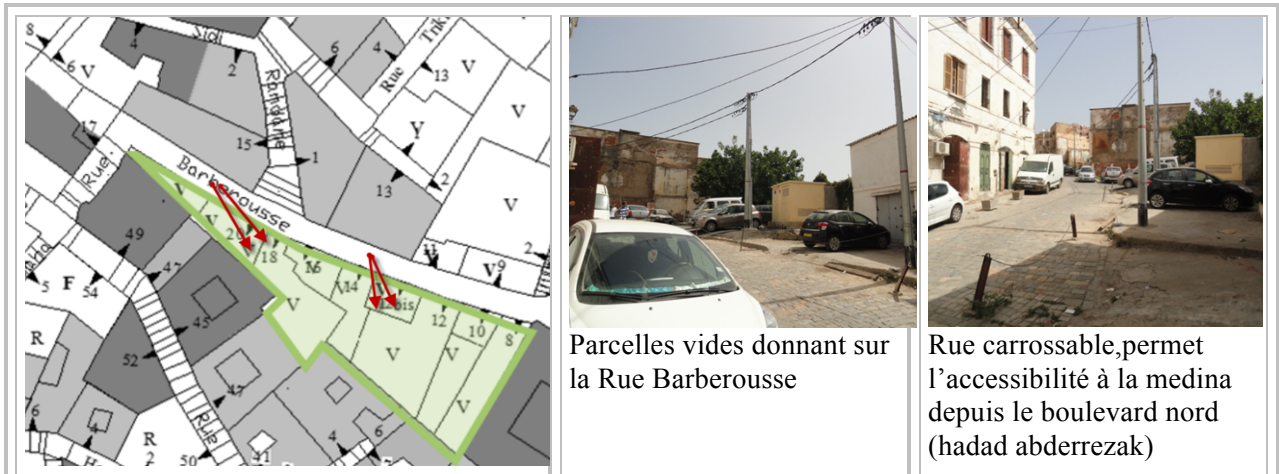
Figure 82 : Appropriation des parcelles issues de l'effondrement des bâtisses ,espaces aménagés en aire de stationnement .
