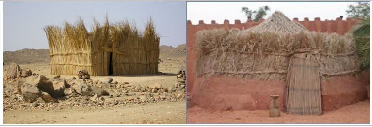
Photo 34: « Ikber », un modèle de construction ancestral bien préservé par les Touaregs du Tassili (photo du milieu)
