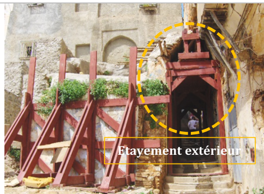
Photo 41 : Travaux de mesure d'urgence dans le Sabat Brahim Fateh , avant et après
