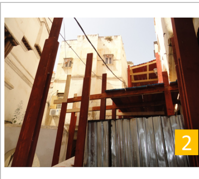
Photo 62: Etaielements des bâtisses dans la rue sidi Driss Hamidouche
