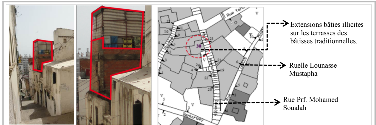
Figure 78 : Rajout sur terrasse non conforme à la réglementation, habitabilité réduite
