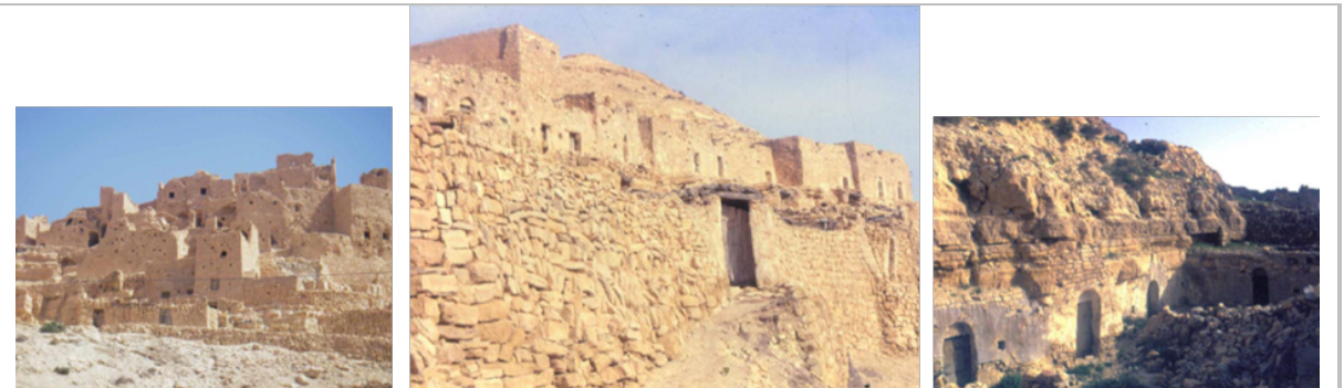
Photo 13 : Habitations troglodyte de type latéral en état de dégradation
