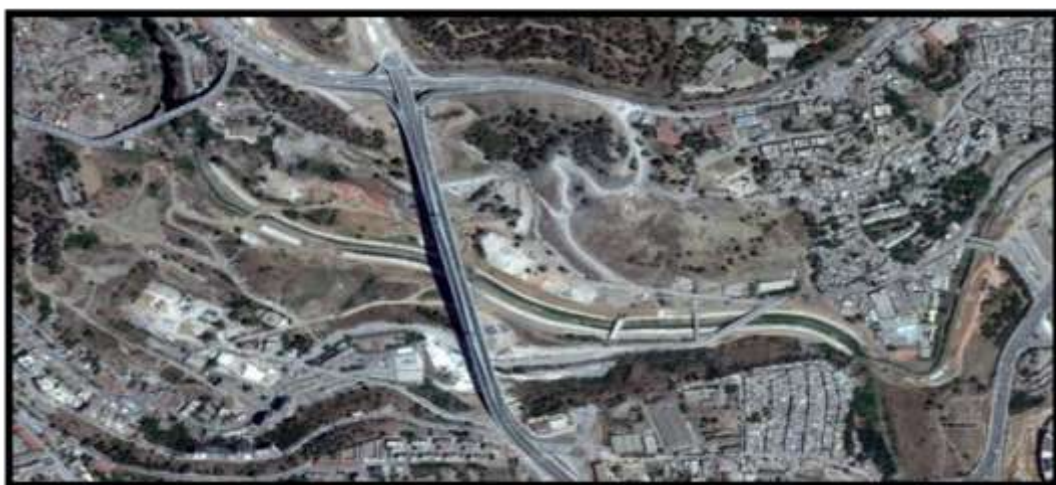
Photo 21 : Le viaduc Salah Bey à Constantine métropole (Vue aérienne)
