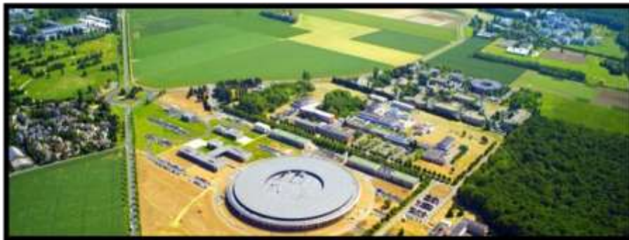
Photo 12 : Vue aérienne du quartier du Moulon - Plateau de Saclay
