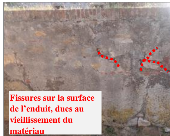
Figure 162 Couronnement du parapet de la muraille avec des lignes de briques pleines disposées verticalement en boutisses. Source : auteur
