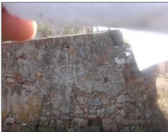
Figure 163 Dégradation du mur soutenant le chemin de ronde par une cause probable liée à l'agression humaine.
