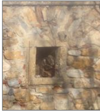
Figure 139 Typologie 2 : Meurtrière carrée avec cadrage en pierre de taille et linteau en arc cintré. Source : auteur
