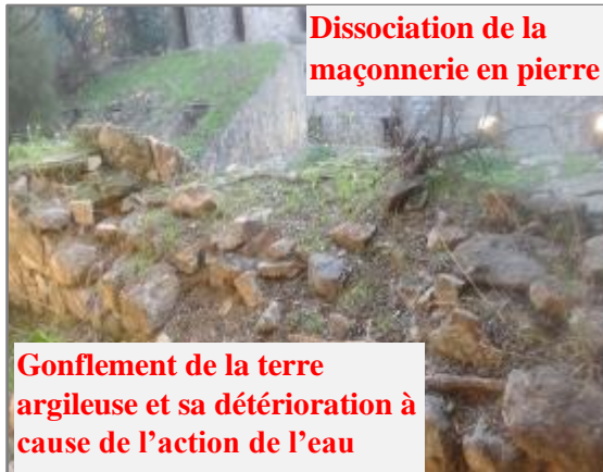
Figure 165 Dissociation de la maçonnerie par l'action de la pluie sur la terre argileuse. Source : auteur
