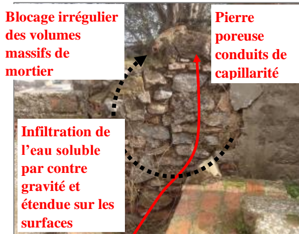
Figure 185 Pathologies dues à la dégradation des matériaux et au vieillissement de la construction, la tour T6. Source : auteur.
