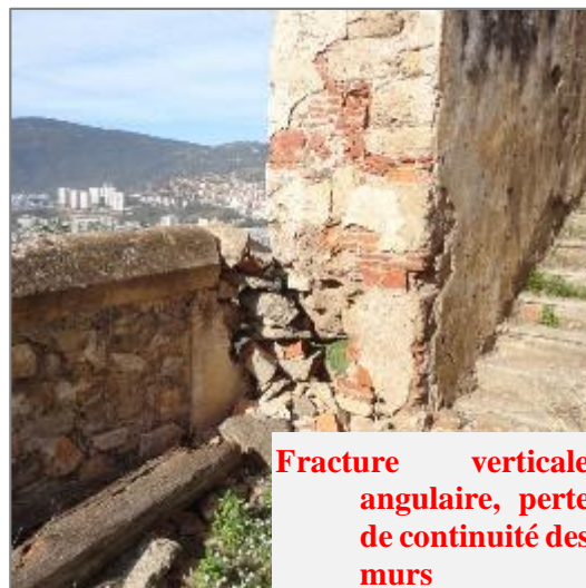
Figure 154 Une fracture introduite par une fraction verticale à l'angle, due à une différence des capacités portantes des deux murs. Source : auteur
