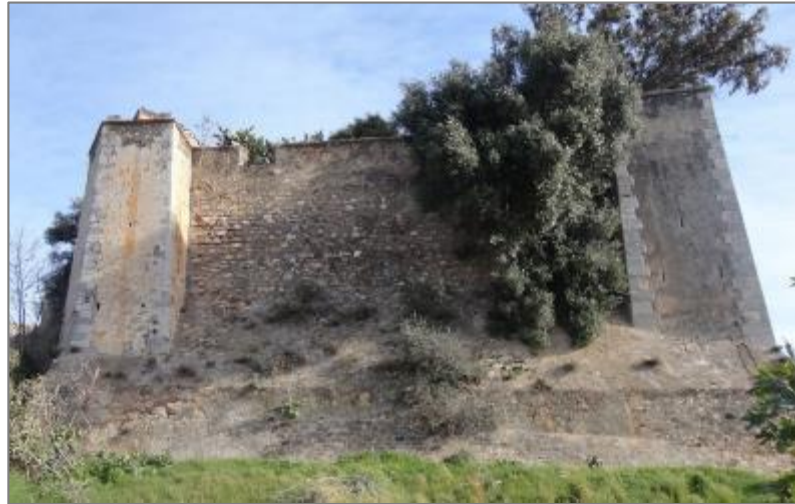
Figure 172 Les bastions, les réduits de la Casbah, des contreforts incrustés dans un escarpement difficile en blocage massif. Source : auteur.
