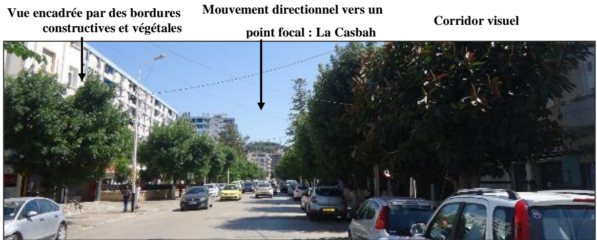
Figure 93 Vue prise à partir de la rue Rondon, quartier Nord Beauséjour, perspective intéressante, composantes paysagères lisibles et compréhensible ; la muraille Nord de la Casbah.
