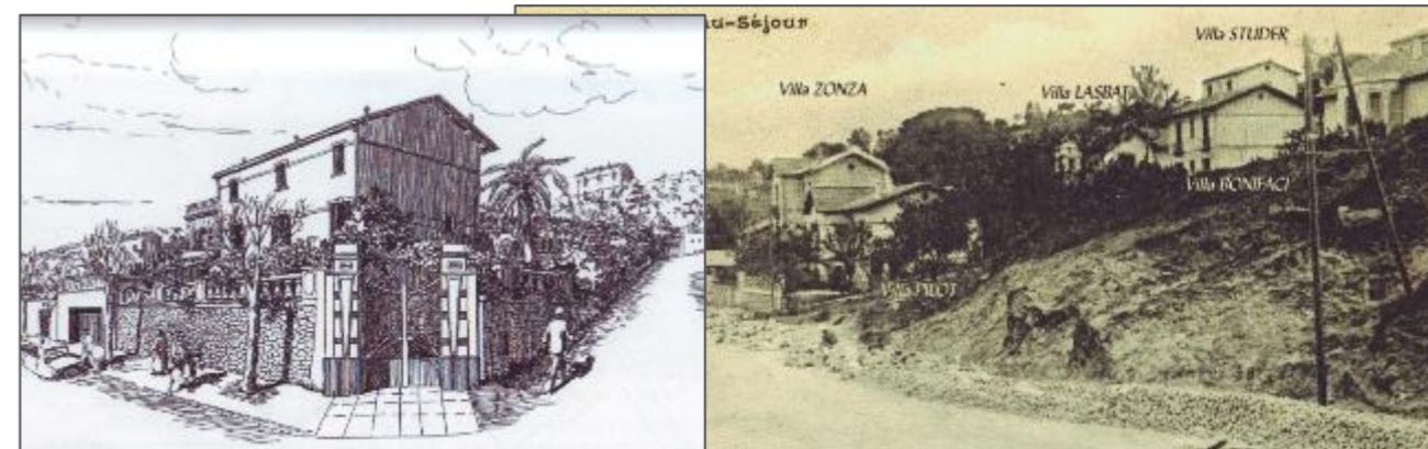
Figure 70 Quartier pavillonnaire Beauséjour sur les coteaux de la colline de la Casbah. Source : Roger Rosso, 2006.
