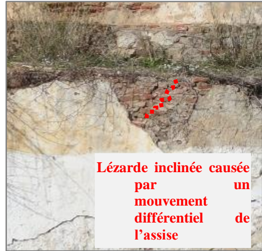
Figure 153 Une lézarde inclinée de cisaillement induite par l'instabilité de l'assise. Source : auteur
