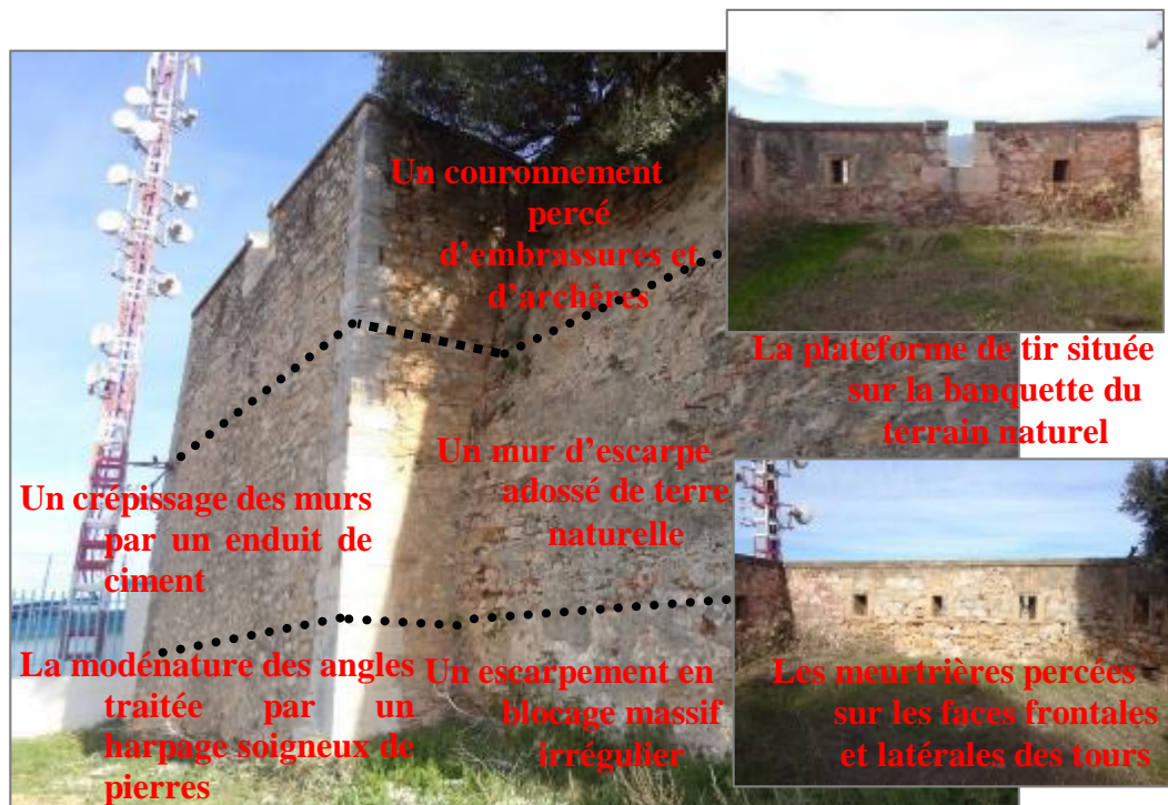
Figure 169 Les caractéristiques typologiques des tours de l'enceinte fortifiée. Source : auteur.
