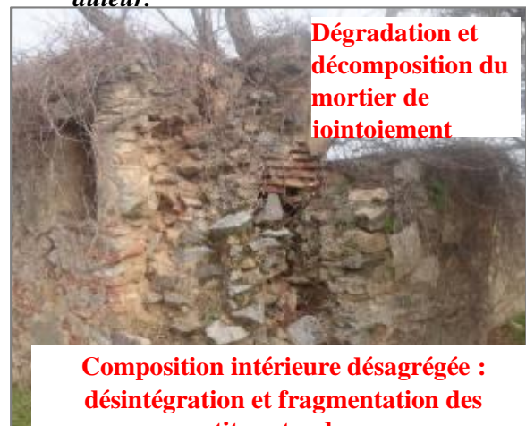
Figure 185 Pathologies dues à la dégradation des matériaux et au vieillissement de la construction, la tour T6. Source : auteur.
