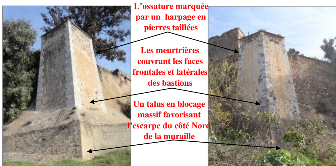
Figure 173 Les bastions, tourelles nettement saillantes au-devant des courtines, abritant des salles souterraines et percées de meurtrières sur leurs faces frontales et latérales. Source : auteur.
