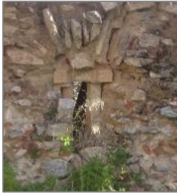
Figure 138 Typologie 1 : Meurtrière de forme irrégulière cadrage en pierre de taille et linteau en arc cintré. Source : auteur
