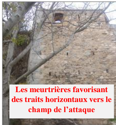
Figure 170: Les ouvertures de tir se chevauchant sur les surfaces des tours pour couvrir les champs de tirs. Source : auteur.
