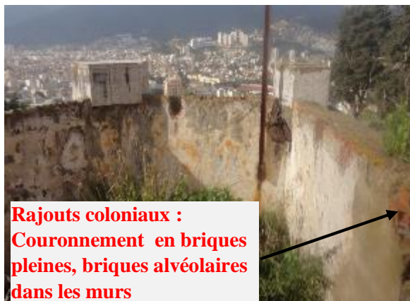
Figure 190 Les transformations apportées au mur frontal Nord : Rajouts de matériaux non adaptables avec la maçonnerie traditionnelle, le bastion T9. Source : auteur.
