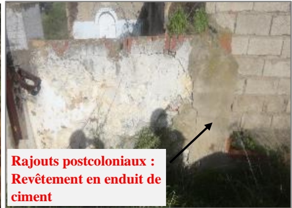
Figure 190 Les transformations apportées au mur frontal Nord : Rajouts de matériaux non adaptables avec la maçonnerie traditionnelle, le bastion T9. Source : auteur.
