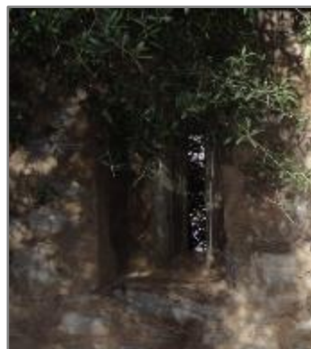
Figure 142 Typologie 4 : Meurtrière avec niche intérieure sans cadrage extérieur. Source : auteur
