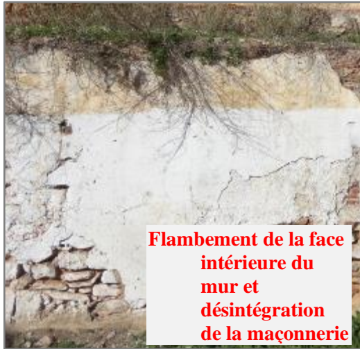
Figure 152 Flambement de la face intérieure du mur entraîné par une fraction verticale interne liée à l'excès de compression.
