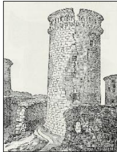
Figure 16 Elévation extérieure du donjon de Coucy. Source : http://www.montjoye.net
