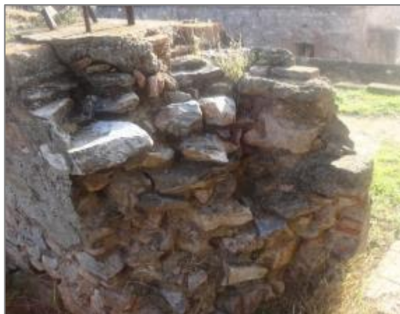
Figure 161 Fragment de mur soutenant le chemin de ronde : appareil irrégulier composés de pierres et des subsistances d'une maçonnerie ancienne. Source : auteur
