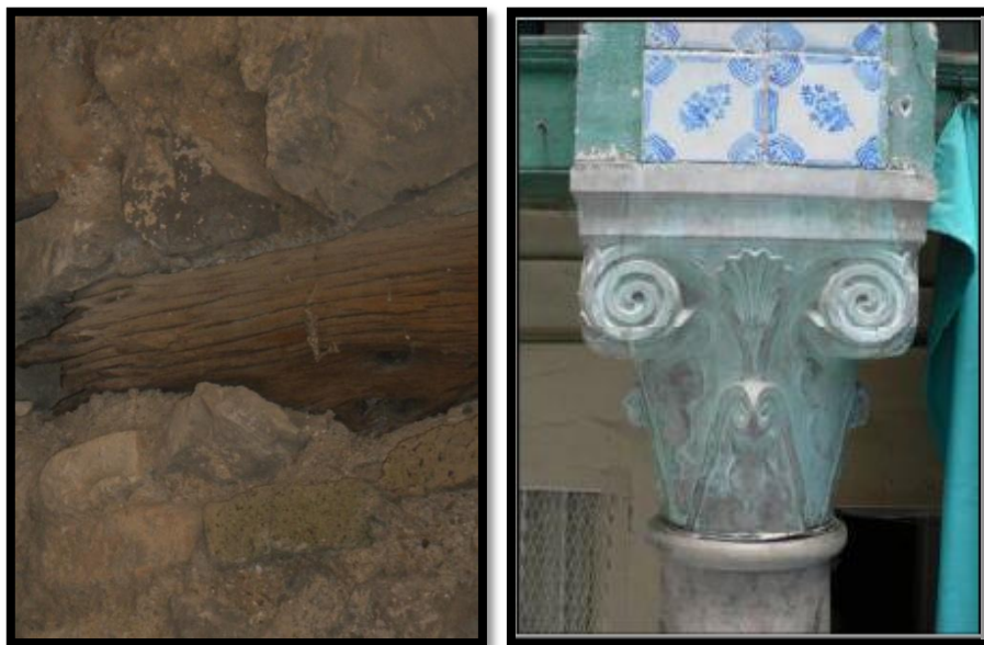
Figure V.11 &V.12 : en haut à gauche rondin du bois elaraar dans les murs (source : auteur.2013). À droite le réemploi des chapiteaux d'une construction ancienne (source : DEKOUMI. Djamel. 2007).
