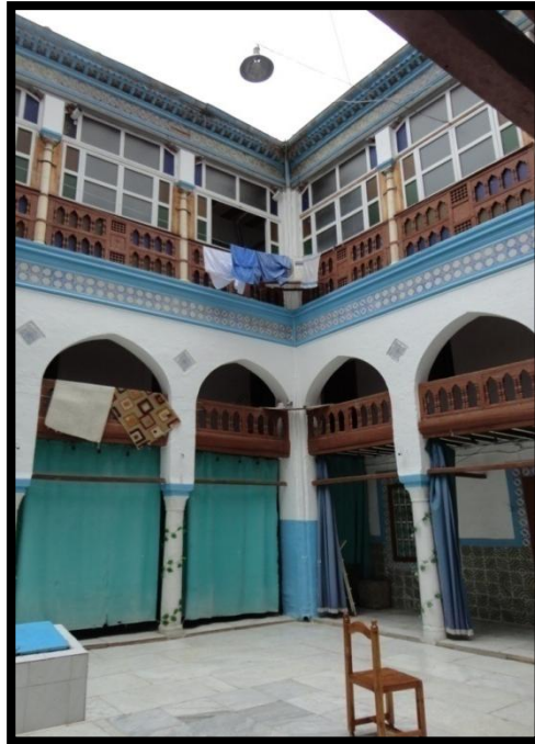
Figure V.23 : Vitrage des galeries et utilisation des rideaux au niveau du patio (source : auteur.2014)
