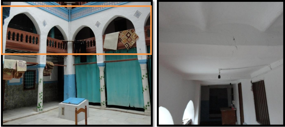
Figure V.20 & V.21: le niveau de Salaam de l'extérieur et de l'intérieur (source : auteur.2014)
