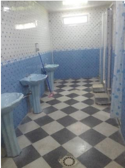
Figure 9: salle de douche de l'unité d'hospitalisation de l'EHSP El Razi. Source : Auteur.
