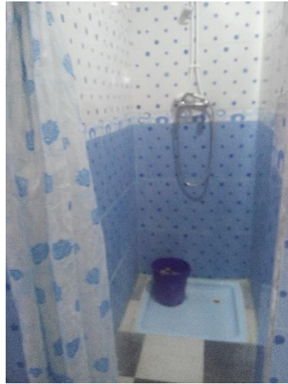
Figure 10: salle de douche de l'unité d'hospitalisation de l'EHSP El Razi. Source : Auteur.
