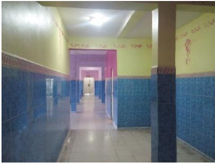
Figure 1: espace de circulation de l'unité d'hospitalisation de l'ESHV El Razi. Source : Auteur.
