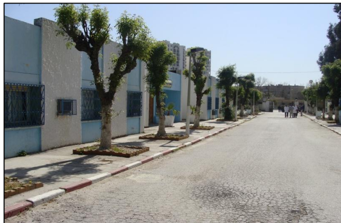
Figure 3. 9: façade d'une l'unité d'hospitalisation de l'EHS El Razi. Source : Site de la DSP de la wilaya d'Annaba, 2016.
