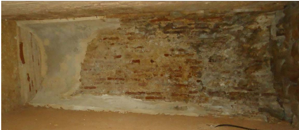
Fig.140 : Habillage de la voute en berceau chambre Est, patio 2.
