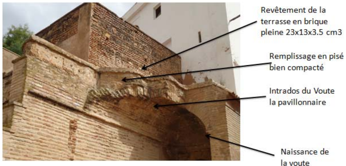
Fig.107 : Détail de la voûte pavillonnaire tronquée, chambre Est, Patio Principale. Source : Auteur
