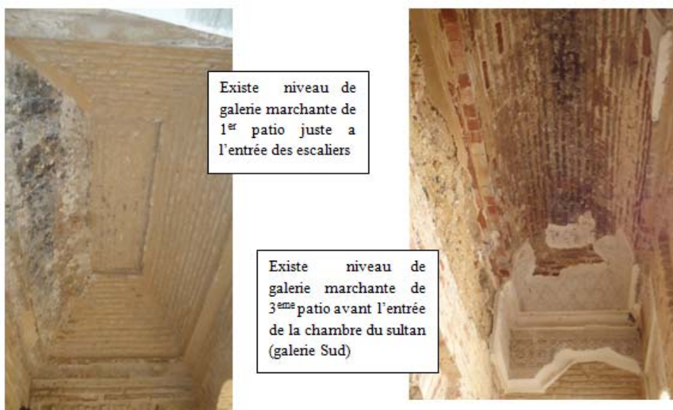
Fig.106 : Patio 1et 3 : Toiture en voute pavillonnaire tronquée. Source : Auteur 2015
