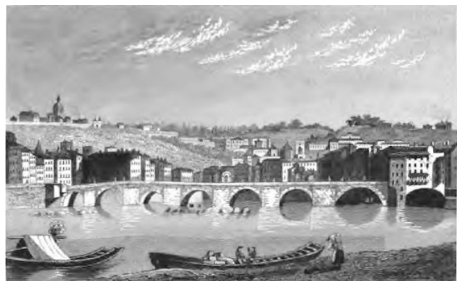
Fig.52 : Pont du change de Lyon en 1838. Source : /www.art-et-histoire.com/pont de change à lyon.
