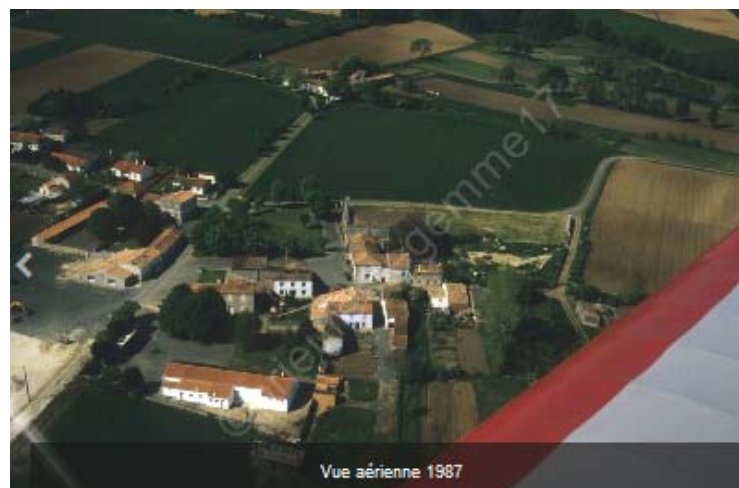
Figure 37 : Vue aérienne sur site date de 1987. Source : site web http://prieurestegemme17.jimdo.com/le-relevé
