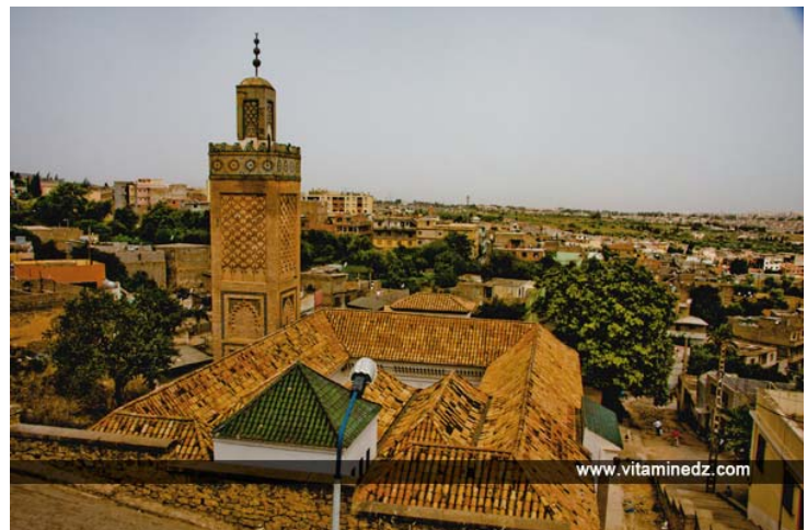
Fig. 70 : Vue d'ensemble sur la mosquée de Sidi El Haloui Source : www.vitamedz.com
