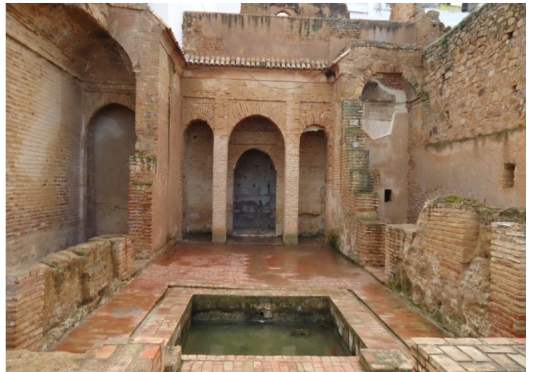
Fig. 92 : Vue sur le grand patio (A) Source : Auteur 2013.
