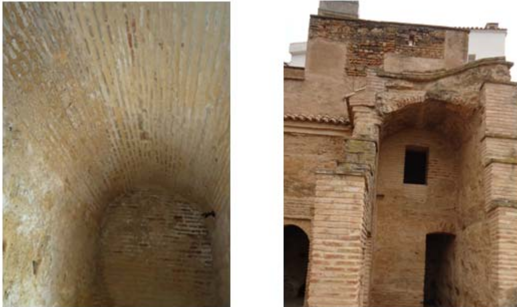
Fig.105 : Patio 2, Voute en Berceau au niveau des deux chambres Est et Ouest . Source : Auteur 2015
