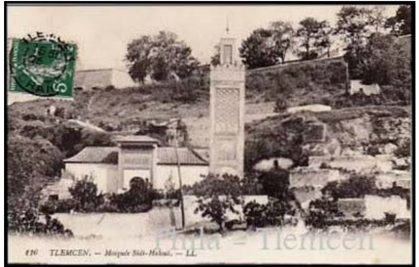
Fig. 68 : Vue d'ensemble sur la mosquée de Sidi El Haloui Source : Georges Marçais à 1927.
