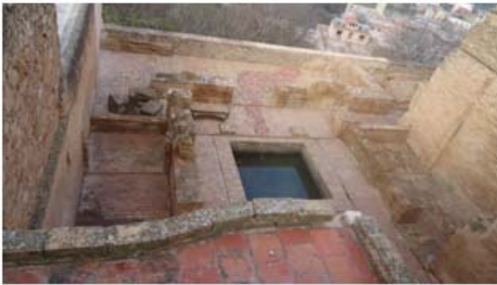
Fig.127 : Revêtement de la terrasse de Dar Es Sultan en brique pleine.
