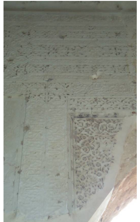
Fig.133: Revêtement des arcs plein ceintre en stuc en plâtre galerie de 1 er patio et la chambre de Sultan patio 3. Source : Auteur 2014.
