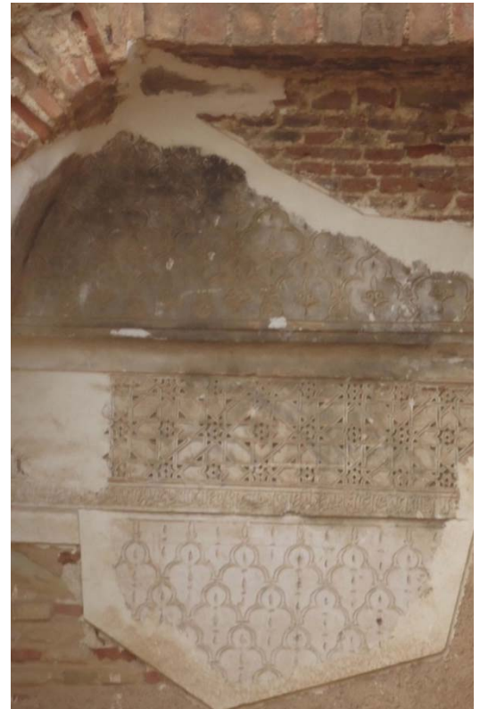
Fig.130 : la décoration murale en stuc de plâtre, Dar Es Sultan Gorfa Ouest de 3 ème patio. Source : Auteur 2015.
