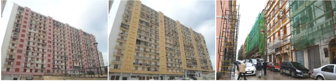
Figure 35 : La réhabilitation du parc immobilier à Constantine
