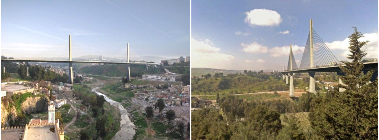
Figure 24 : Le Viaduc de l'indépendance
