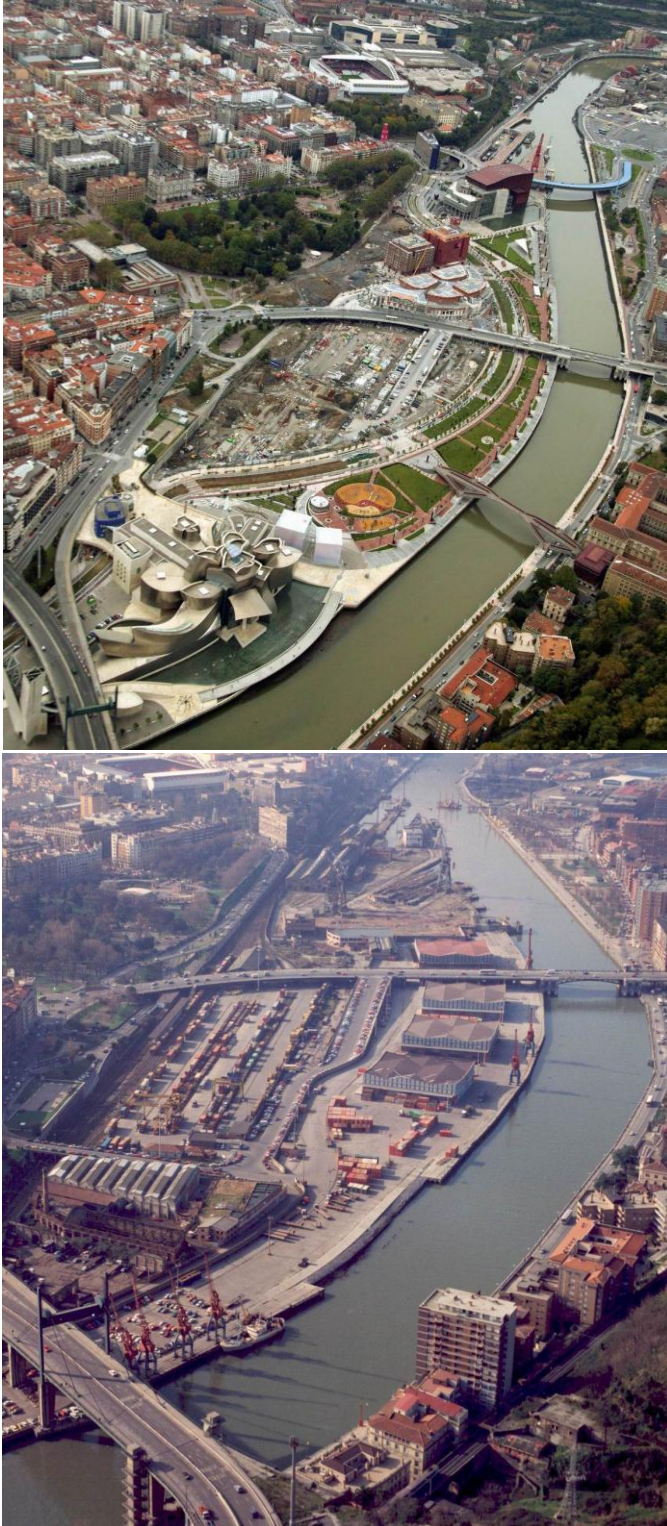
Figure 7.L'évolution du quartier d'Abandoibarra. Avant et après le projet. Source : Bilbao Ria2000.
