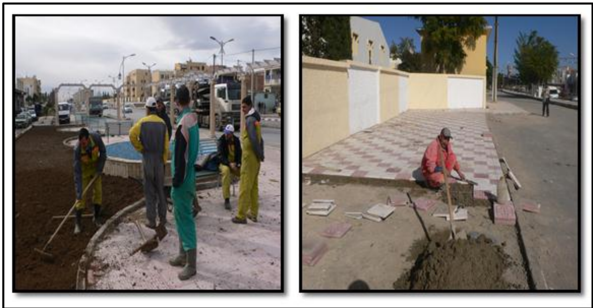
Photo N° 14 : Aménagement des placettes et Réparation des bordures, cité Cheikh El Aifa (POS ZA02) Source : BET HAZZI.
