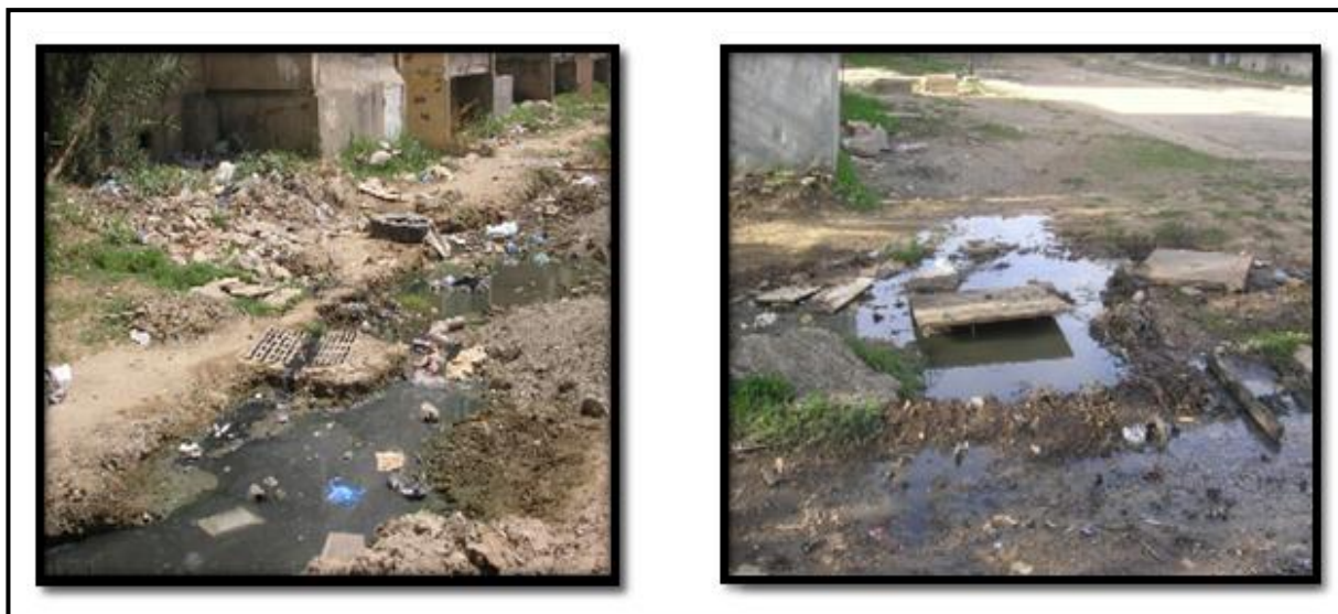
Photo N° 02 : AIN ARNAT, Débordement des eaux au niveau des regards, et Fuite de l'eau potable.
