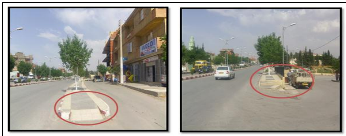
Photo N° 07 : Amélioration des tracés des voies et la construction des murs de soutènement. Boulevard RN05 Source : BET HAZZI.
