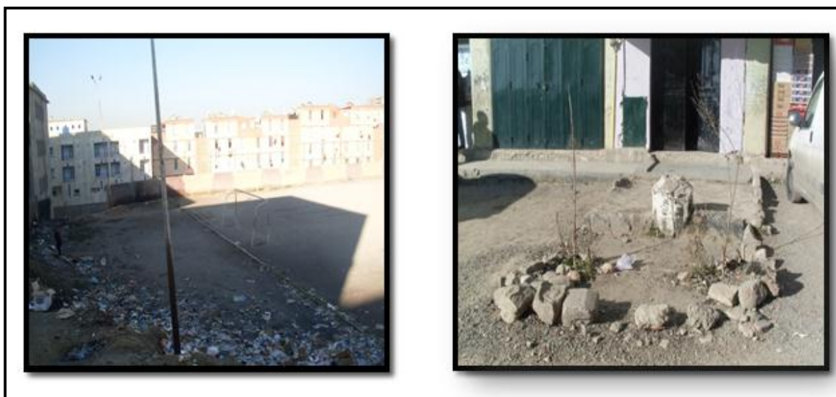
Photo N° 06 : AIN ARNT, Dégradation très avancé ainsi la Pauvreté des espaces de jeux et la marginalisation des espaces verts.
