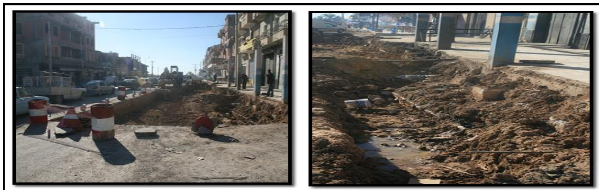
Photo N° 08: Les travaux d'assainissement, Boulevard RN05. Source : BET HAZZI.
