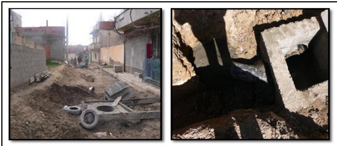
Photo N° 13 : les travaux d'assainissement, cité Cheikh El Aifa(POS ZA02). Source : BET HAZZI.
