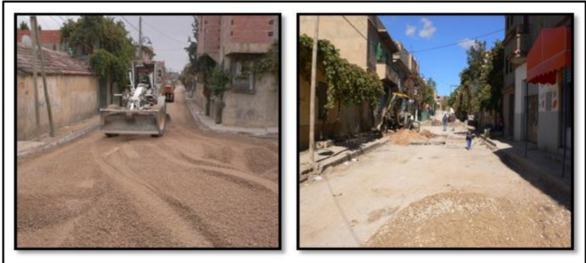
Photo N° 12 : les travaux de la voirie cité Cheikh El Aifa(POS ZA02). Source : BET HAZZI.
