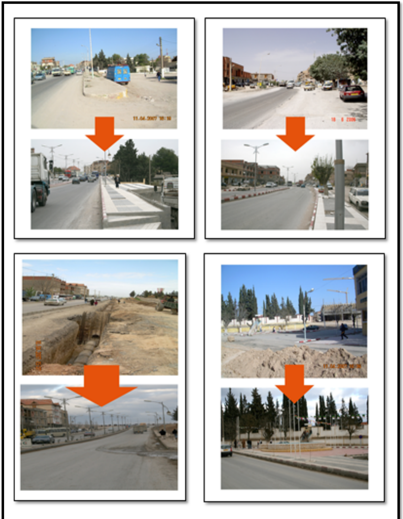
Photo 11 : Le boulevard principal RN05 avant et après les travaux d'amélioration urbaine.
