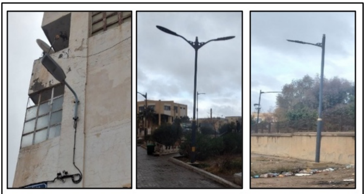
Photo 05 : l'insuffisance des dispositifs d'éclairage public. Source : BET HAZZI.
