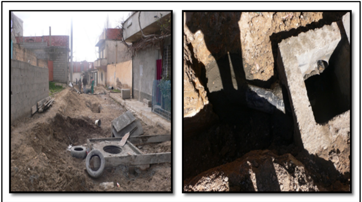
Photo 13 : les travaux d'assainissement, cité Cheikh El Aifa(POS ZA02).
