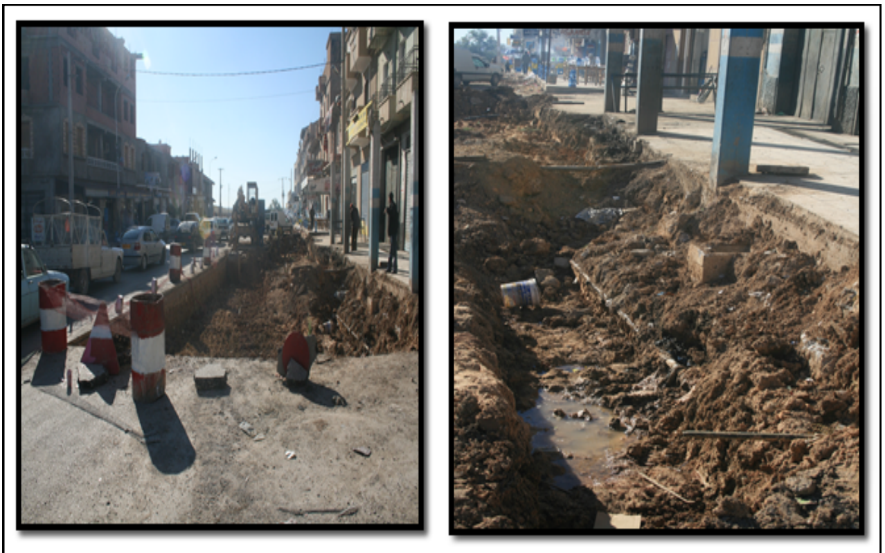
Photo 08: Les travaux d'assainissement, Boulevard RN05.
