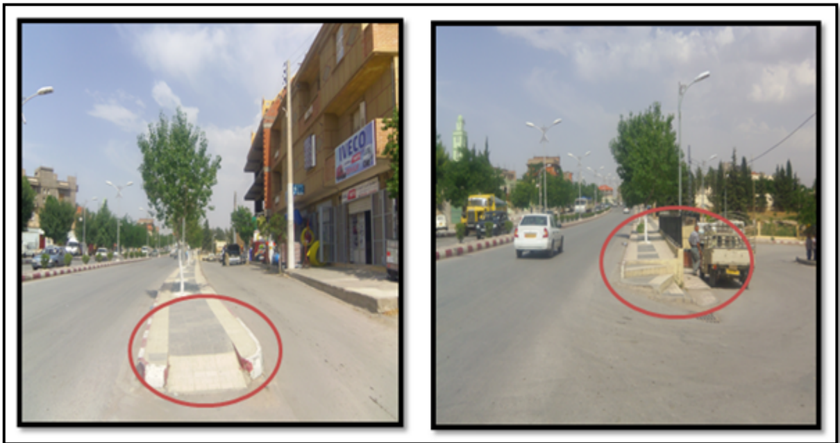
Photo 07 : Amélioration des tracés des voies et la construction des murs de soutènement. Boulevard RN05 Source : BET HAZZI.
