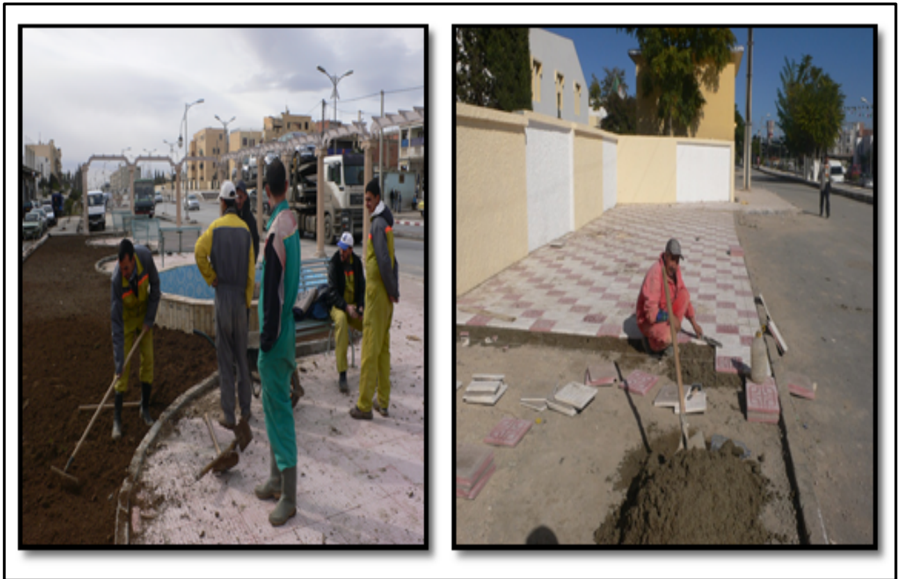
Photo 14 : Aménagement des placettes et Réparation des bordures, cité Cheikh El Aifa (POS ZA02) Source : BET HAZZI.
