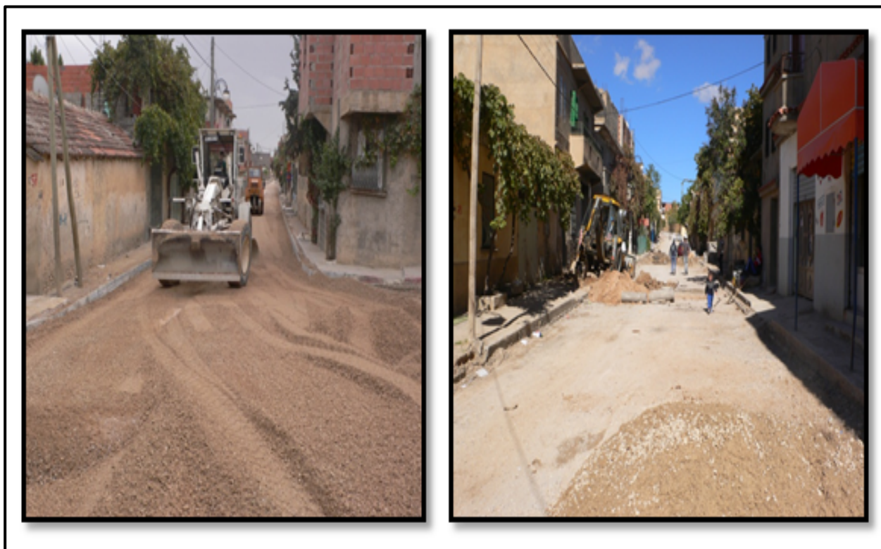
Photo 12 : les travaux de la voirie cité Cheikh El Aifa(POS ZA02).
