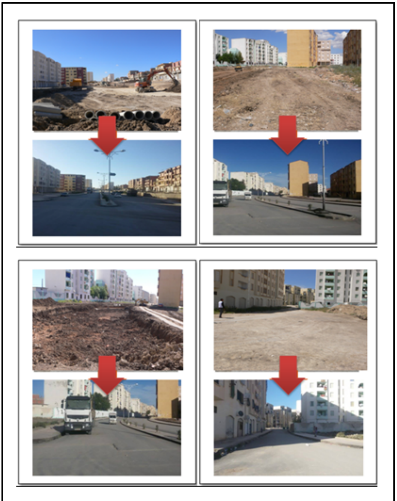
Photo 17 : Le boulevard des 470 lots /LSP (SAU10). Avant et après l'amélioration urbaine. Source : BET HAZZI.
