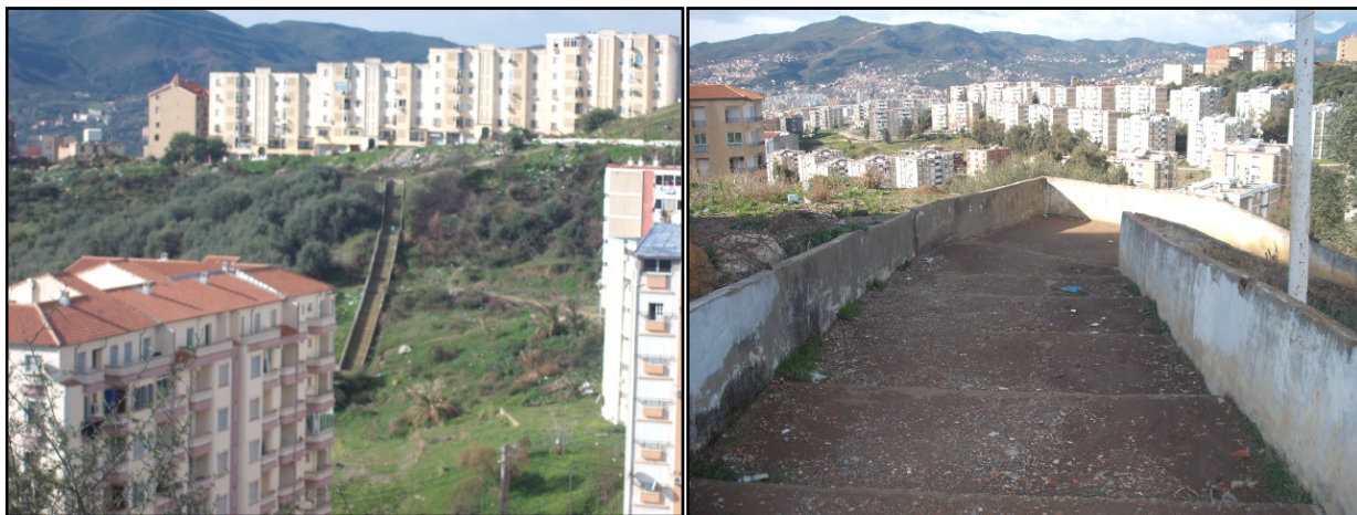
Image 7 : Des escaliers à mi-chemin entre la rampe et la piste.
