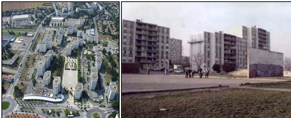
Image 28 : Le quartier du Prainet, avant (à droite) et après la requalification (à gauche).
