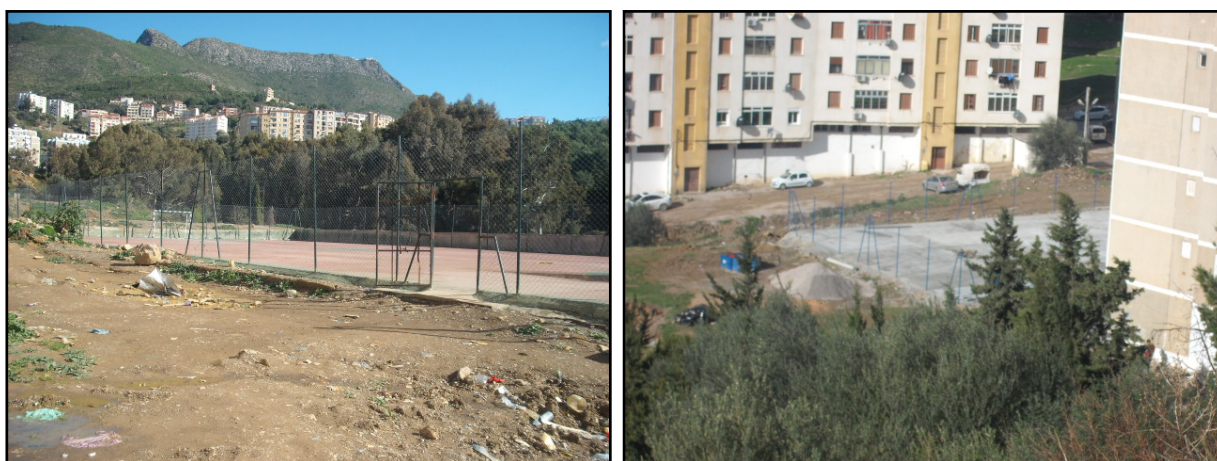
Image 6 : photo d'un terrain de jeu (à gauche) et d'un autre en cours de réalisation (à droite).
