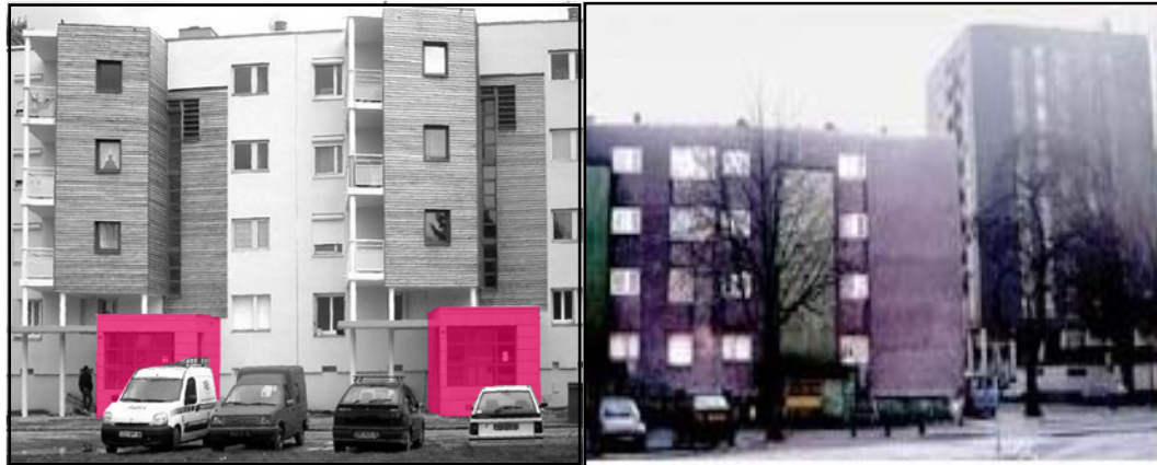
Image 15 : Après (à gauche) et avant (à droite) l'intervention sur les pieds d'immeubles (accès).
