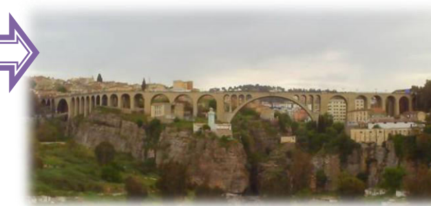
Figure 44 : Le Pont de Sidi Rached
