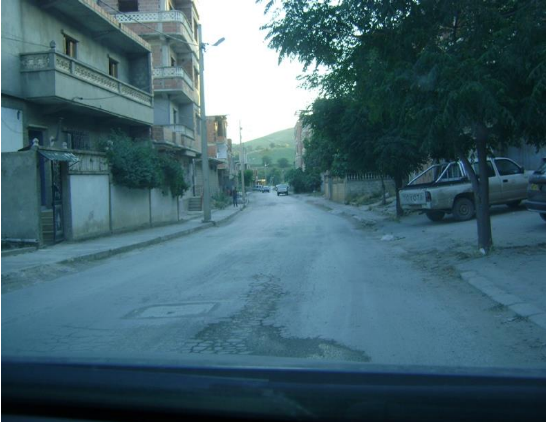
PHOTO N° 18 : Routes à bitumées
