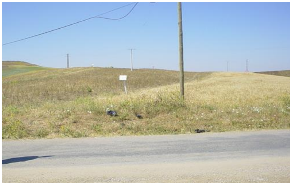
PHOTO N° 08 : Pipeline et ligne électrique formant un couloir de servitudes important
