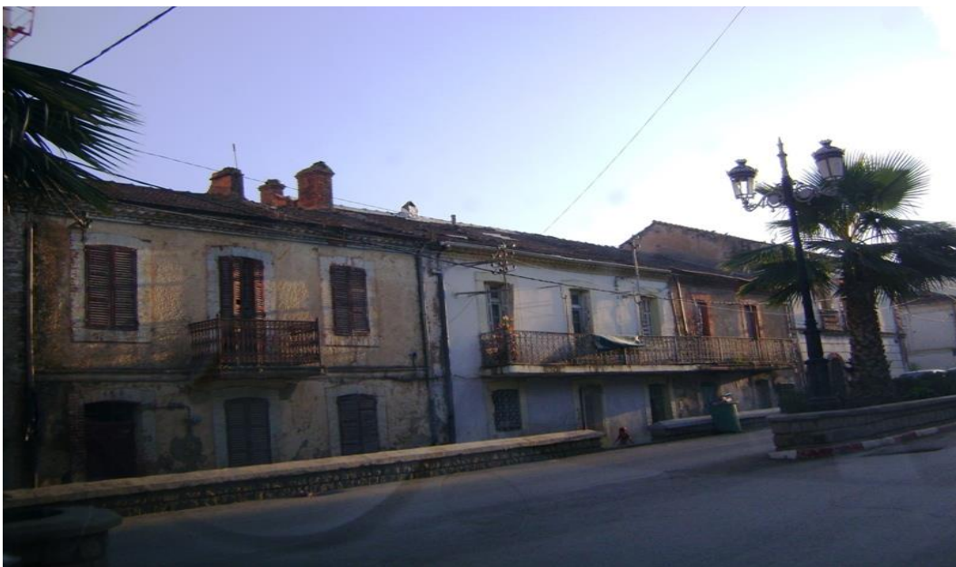
PHOTO N° 13 : construction de type colonial
