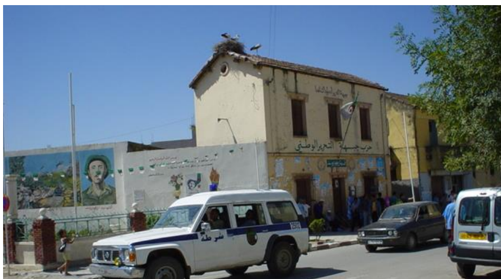
PHOTO N° 12 : Ancienne Maison cantonnière boulevard de l'indépendance
