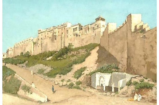
Figure 114. Rempart de la Citadelle (coté Sud), source : Collection B. Venis, http://algerroi.fr
