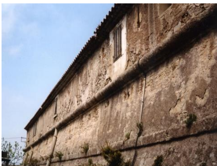
Figure 44. Aile gauche du fort de l'Eguillette, avant travaux, source: http://insitu.revues.org/275
