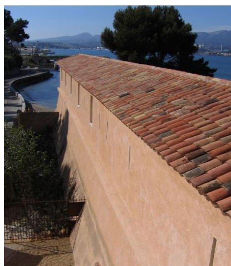
Figure 45. Aile gauche du fort de l'Eguillette, après travaux, source: http://insitu.revues.org/275
