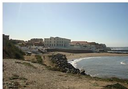
Photo 17. Institut des métiers des arts, source : l'auteur
