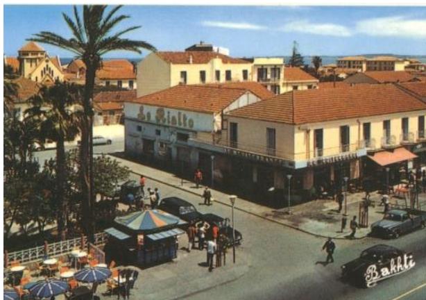
Figure 143. Centre-ville de Bordj El Kiffan : la placette et l'église en arrière-plan
