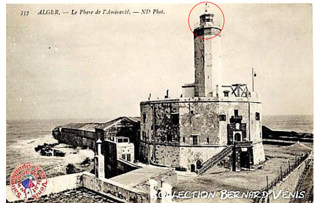
Figure 103. Bordj El Fanar, source : Collection BernardVenis : http://algerroi.fr/Alger/amiraute .
