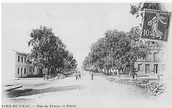
Rue de France
