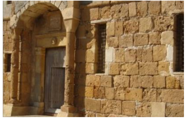
Photo 39. Murs porteurs en pierre de taille Source : l'auteur
