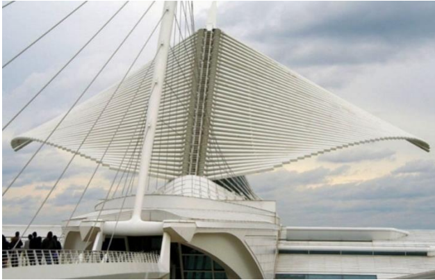
Figure V.11 : Brise-soleil (louvered wall/ Le mur-persiennes), Milwaukee Arts Museum, Etats Unis. Architecte : Santiago Calatrava (Source : http://www.payer.de/tropenarchitektur/troparch013.htm )
