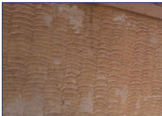
Photo n°60 : Finition d'enduit Source : Auteur, 2012.
