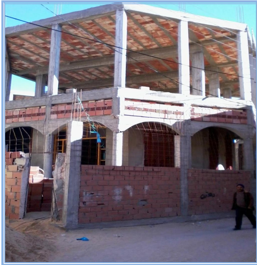
Photo n°73 : Utilisation de matériaux de construction incompatibles aux matériaux d'origine Source : Auteur, 2013.
