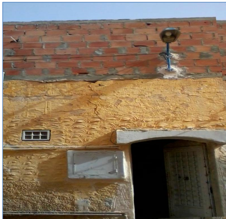
Photo n°75 : La maison a subit quelques transformations (rajout d'une partie de l'étage) afin de subvenir aux nouveaux besoins des occupants. Source : Auteur, 2014.
