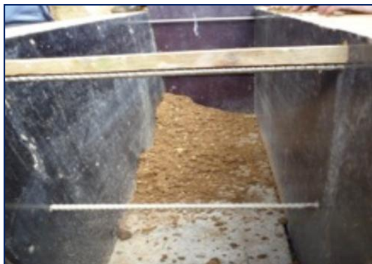
Photo n° 07 : la technique du pisé Source : Delahousse, S, 2011.
