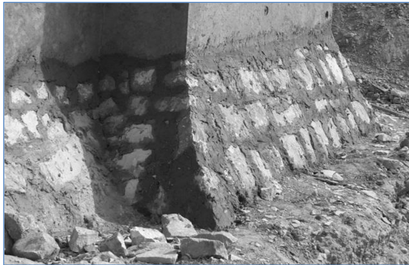
Figure n°44: Renforcement de la base d'un mur élevé par un doublage en pierres
