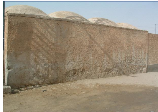
Photo n°58 : Façade aveugle Source : Auteur, 2012.
