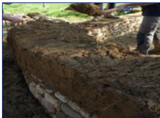
Photo n° 06: la technique de la Bauge Source : Delahousse,S, 2011.
