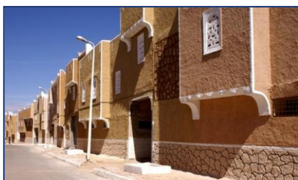
Photo n°33 : Façade urbaine intravertie
