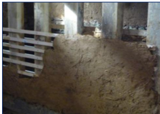
Photo n° 08 : la technique du torchis Source : Delahousse, S, 2011.
