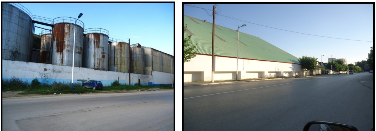
Photo 22 et Photo 23 Vue montrant l'aspect industriel de la zone (Réservoir à carburant, support en friche)
