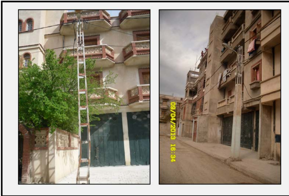
Photo n°76 et 77: exemples du réseau d'électricité et d'éclairage public (par l'auteur 2013)
