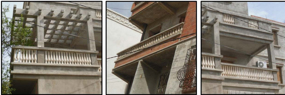
Balcons rectangulaires donnant sur deux façades
