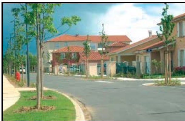
Figure 08 : Un traitement paysager des espaces collectifs : mail planté et cheminements piétons
