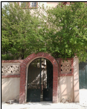
entrée principale en brique pleine avec une porte métallique simple
