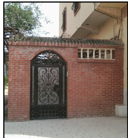
entrée principale en brique pleine avec une porte métallique ornementée en fer forgé
