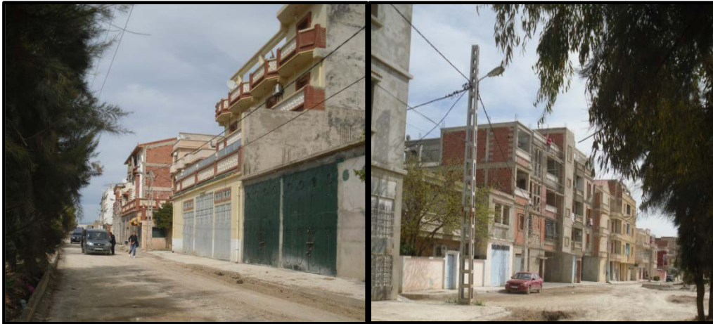
Photos n°48,49 : Images de maisons présentant le contraste entre les façades (Source : l'auteur 2013)
