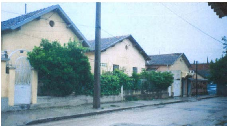
Photo n°25 : L'aspect original du lotissement pavillonnaire de « l'Ex Village Juif ».
