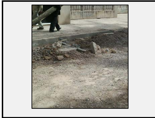
Photos n°78, 79,80: exemples du réseau d'assainissement (par l'auteur 2013)
