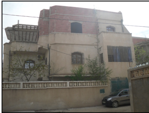
Photos n°43, 44,45 : Images de maisons inachevées présentant le système constructif en béton et les murs en brique rouge (Source : l'auteur 2013)
