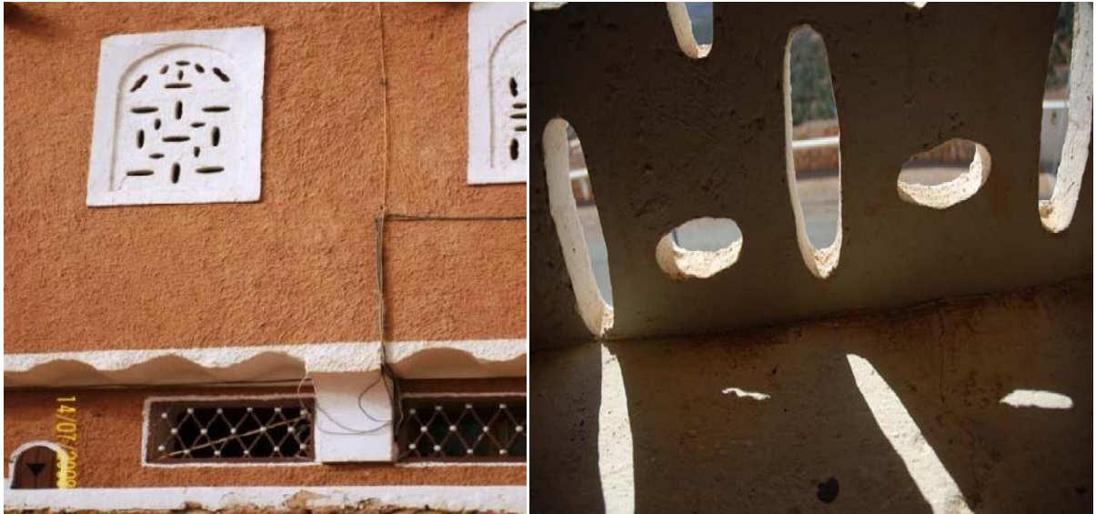
Figure 19: Type de fenêtres et de protection solaire au sein de la cité Tafilelt (Source : Tafilelt.com, 2013)
