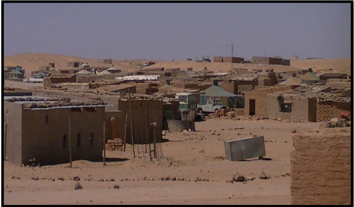
Figure 1 : dégradation des espaces extérieur dans les climats arides (Source : www.diasporasaharaoui.com , 2013)
