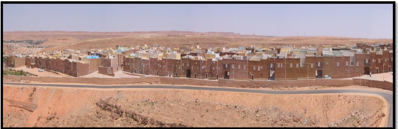
Figure 5 : Vue générale sur la façade urbaine de Tafilelt (Source : www.tafilelt.com , 2012)
