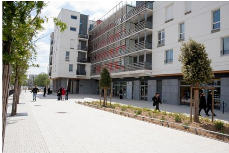
Figure 32 : vue du quartier de La Roseraie
