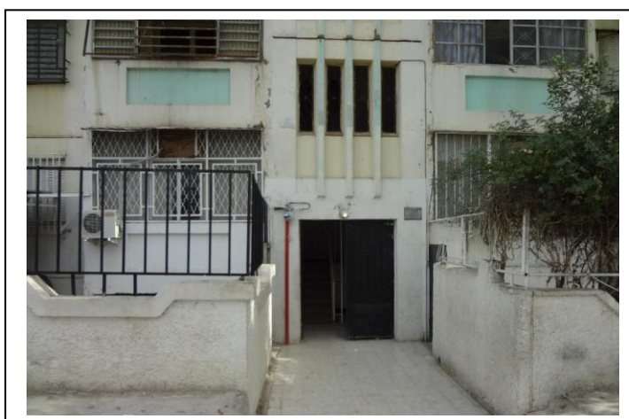
Figure 73: Vue du centre médical du bloc N° 47 dans le groupement résidentiel
