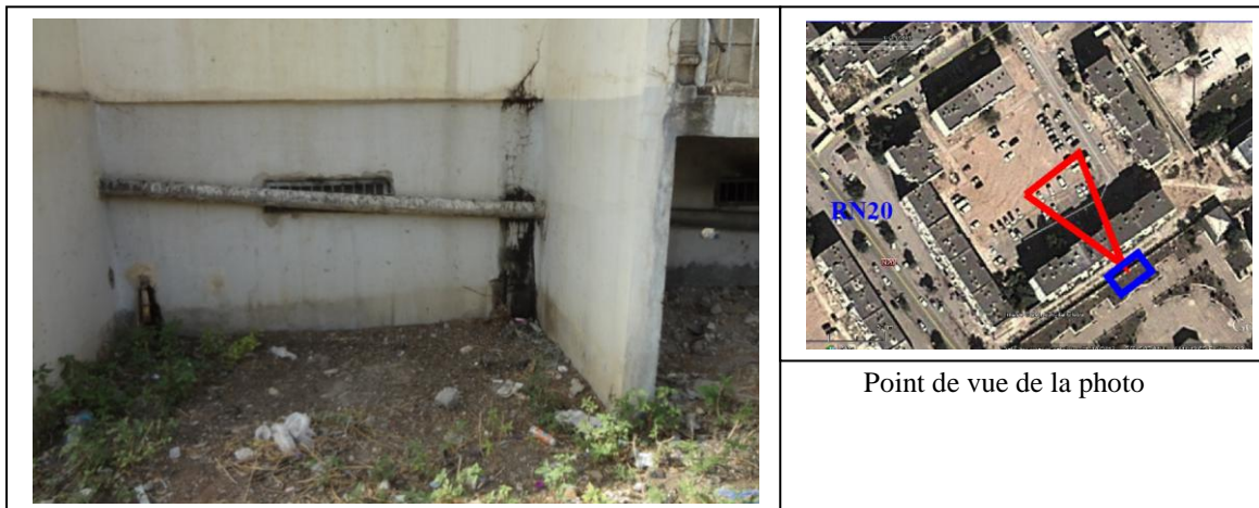
Figure 85: vue de l'assainissement du bloc 47 du groupement résidentiel
