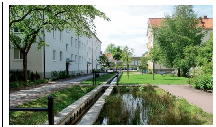
Figure 14 : Exemple de gestion des eaux pluvial par canaux (quartier d'Augustenborg à Malmö)
