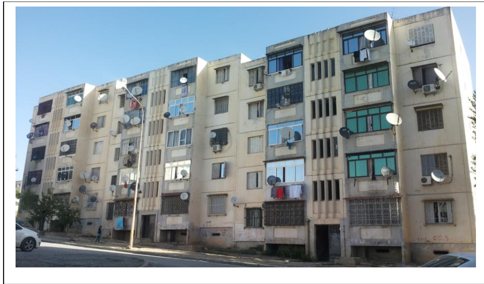
Figure 54 : Vue de l'immeuble (blocs 42-43-44) contenant des appartements F3 et F4 type 1
