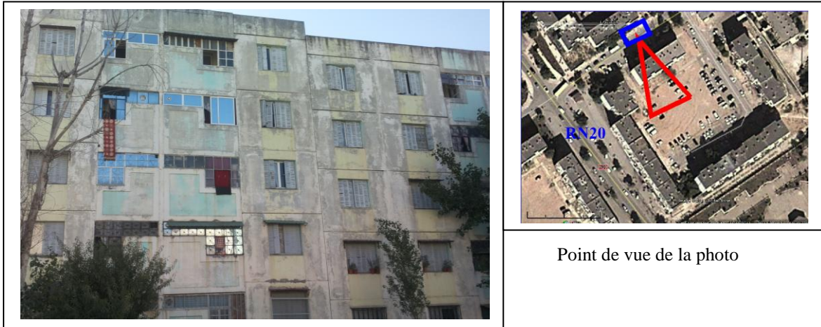
Figure 98: vue de la façade ouest de l'immeuble contenant les blocs 49-50
