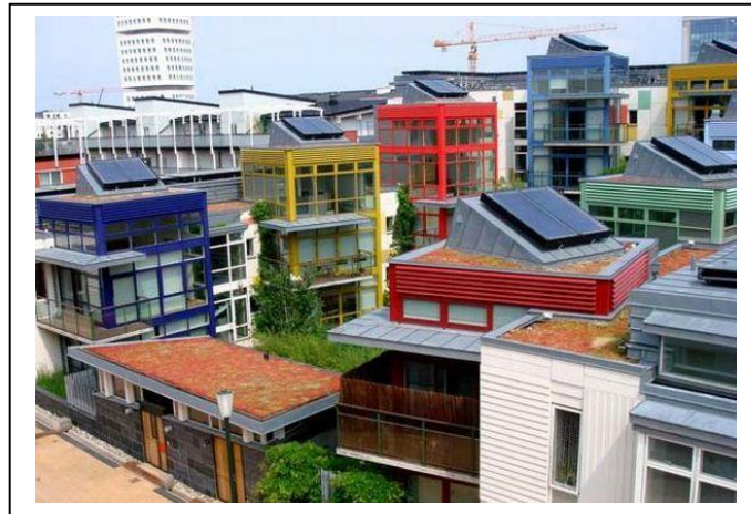
Figure 18 : Les panneaux photovoltaïques sur les toitures- quartier Bo01
