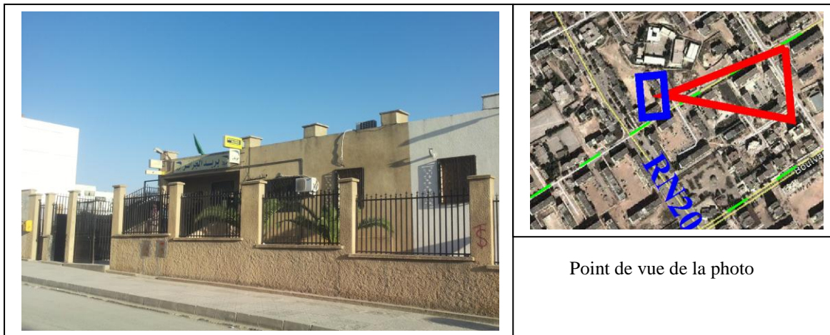
Figure 71: Vue de l'agence postale de la cité des 1013 logements
