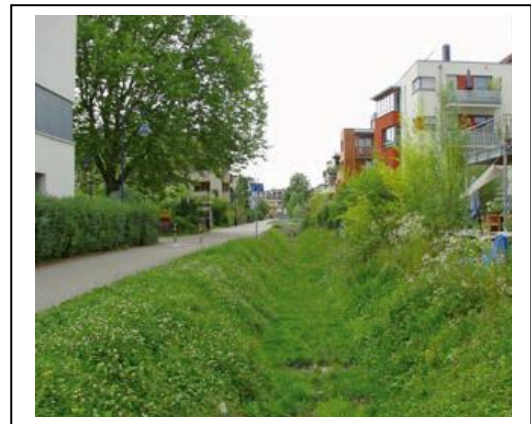
Figure 20 : Faussé de rétention d'eau- quartier Vauban
