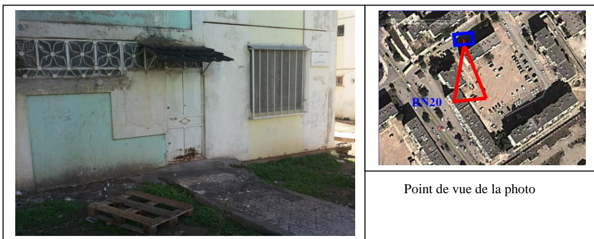
Figure 91: vue de l'accès aménagé par le séchoir du bloc N°50
