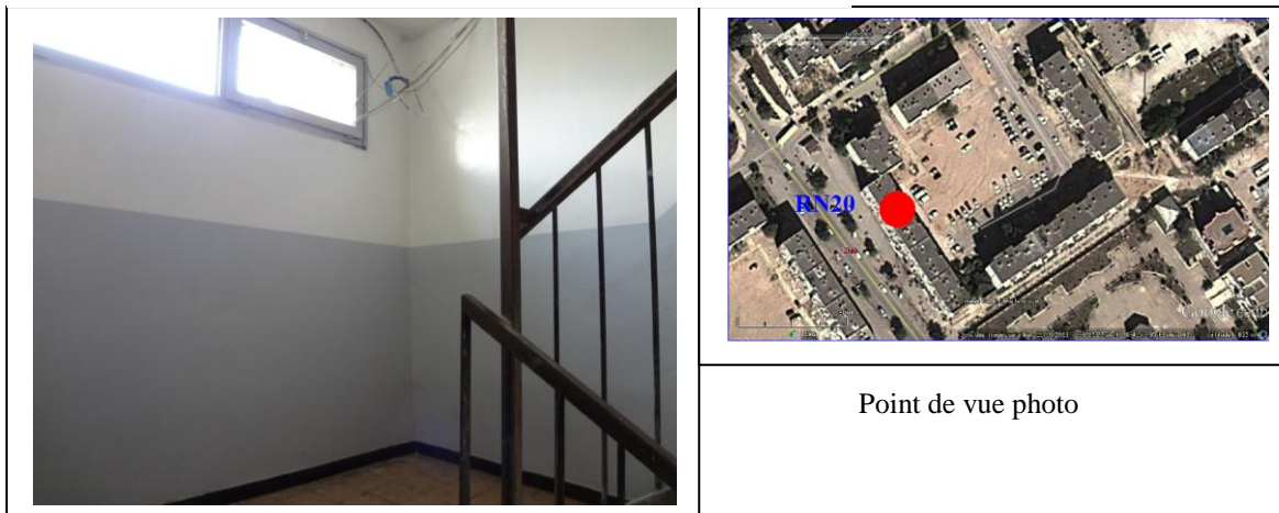
Figure 68: Vue des murs de la cage d'escalier du bloc N°53
