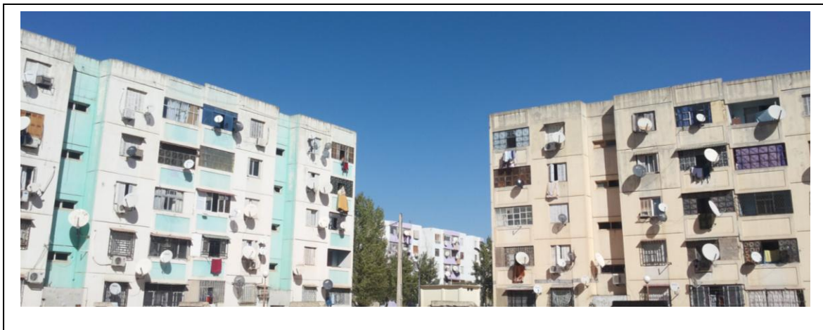
Figure 99: vue des façades de deux immeubles dans le Sud du quartier
