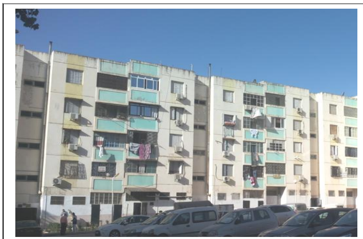
Figure 57 : Vue de la façade Est de l'immeuble avec locaux commerciaux
