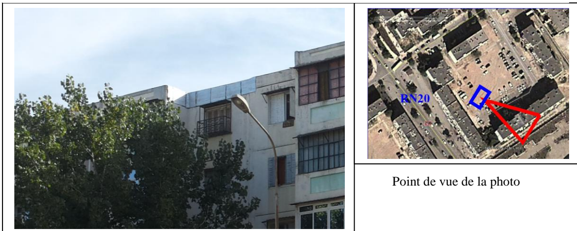
Figure 94: vue de la partie supérieure de la façade du bloc N°46 du groupement résidentiel
