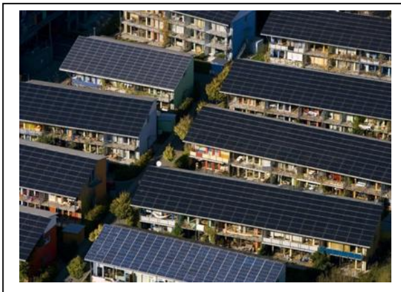
Figure 21 : panneaux solaires- quartier Vauban
