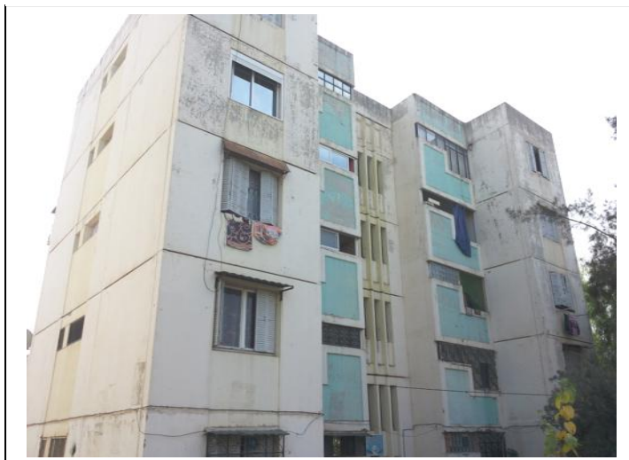
Figure 56 : Vue de la façade Nord du bloc N° 51
