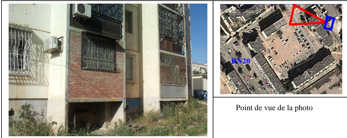
Figure 93: vue de la façade Nord du bloc 42 du groupement résidentiel
