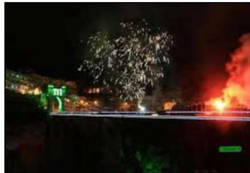
Fig.93. La célébration du centenaire du pont de Sidi M'cid en 2012. Source : Internet.
