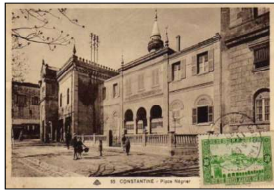
Fig.52.Place Négrier. Source : Archive de Constantine.
