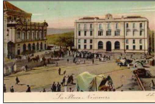
Fig.65. Place du 1 er Novembre (ex-Nemours) et les différents changements avant l'indépendance. Source : archive de Constantine.
