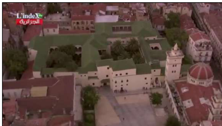
Fig.97. Vue du ciel sur la place SI HAQUES. Source : traitement de l'auteur à partir du documentaire Constantine vue du ciel de Yann Arthur Bertrand 2014.
