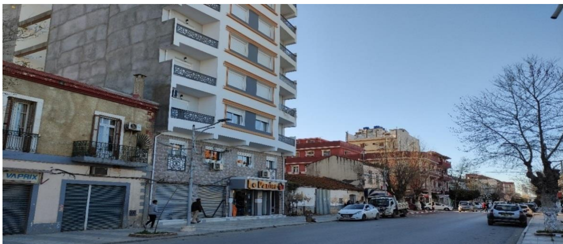
Figure 33. Rénovation et reconstruction de nouvelles habitations au centre-ville de Jijel. Source : Photo prise par Les auteurs (2021).
