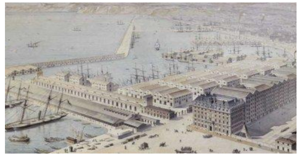
Figure 6.3. Marseille, les docks, les Docks Village, Centre d'Affaires et Commercial
