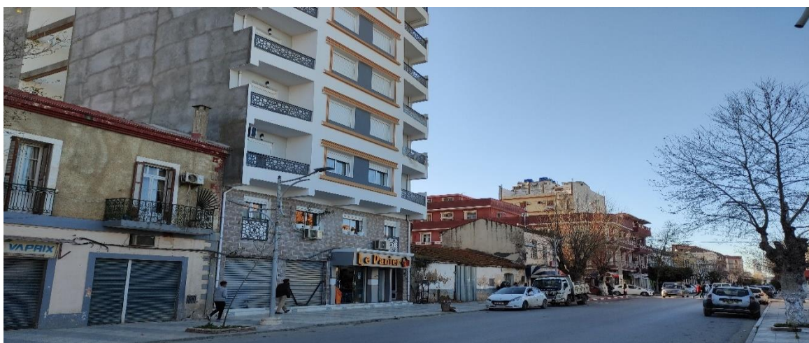
Figure 3.39. Rénovation et reconstruction de nouvelles habitations au centre-ville de Jijel.
