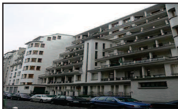
Fig. I. 12 : Henri Sauvage 1922-1927 Immeuble d'habitation ; piscine municipale façade sur la rue des Amiraux, avec les balcons en gradins.
