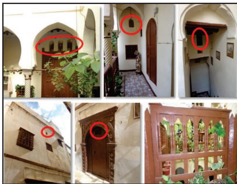
Fig. IV. 32 : Les ouvertures d'aération sur les différentes façades.
