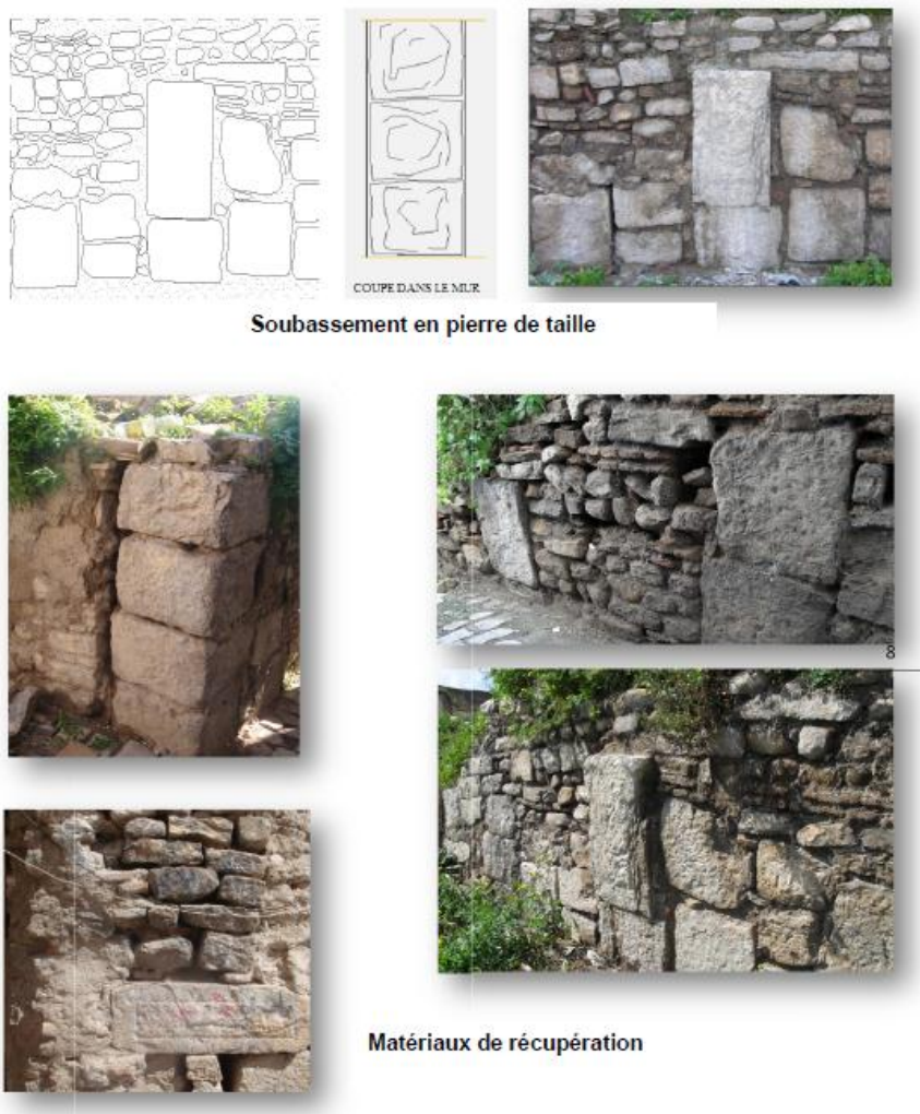
Figure 43 : murs en matériaux de récupération
