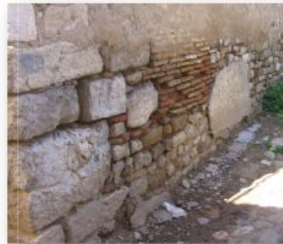
Mur composé de pierres, de moellons et de briques d'une manière désordonnée.
