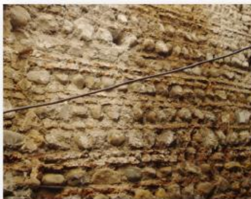
Mur composé d'une rangée de moellons intercalée par deux rangées de briques.
