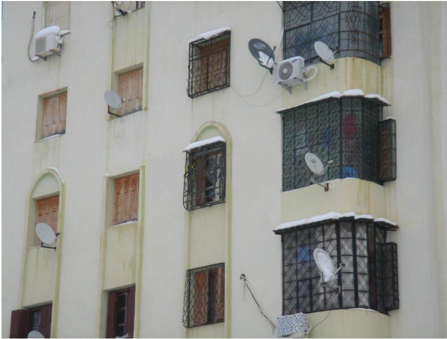
Figure 25: fermeture des ouvertures, nouvelle ville Ali Mendjli Constantine
