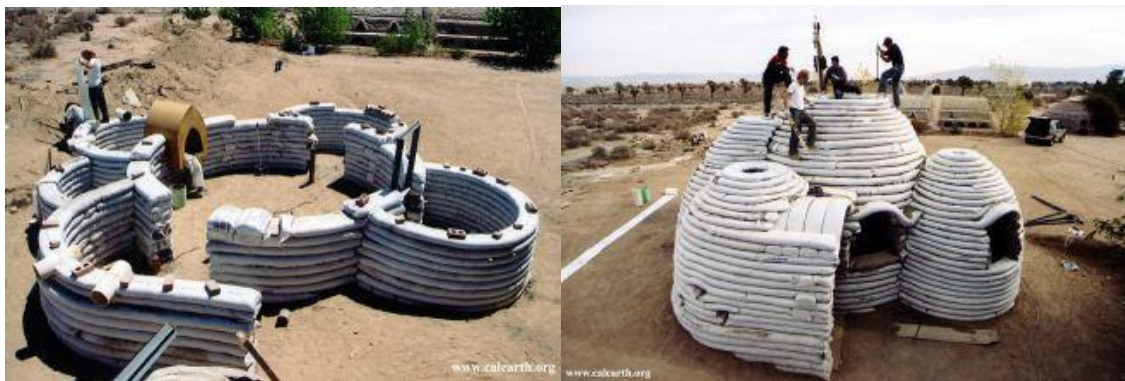
Figure 21: maison éco-dôme en construction
