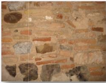
Mur composé de pierres, de moellons et de briques d'une manière désordonnée.
