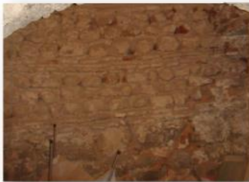
Mur composé de plusieurs rangées de moellons, intercalées par deux rangées de briques.
