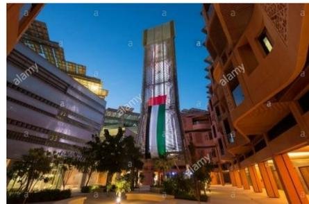
**Photo 16:** La tour de refroidissement du vent à la cour à l'Institut de la science et de la technologie
