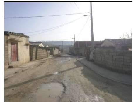
Photo 59 : état de la voirie
