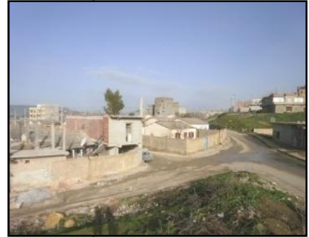
Photo 58 : état de la voirie
