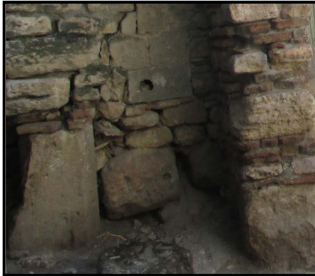
Photo 4.2 : Mur en pierres intercalées de briques cuites.
