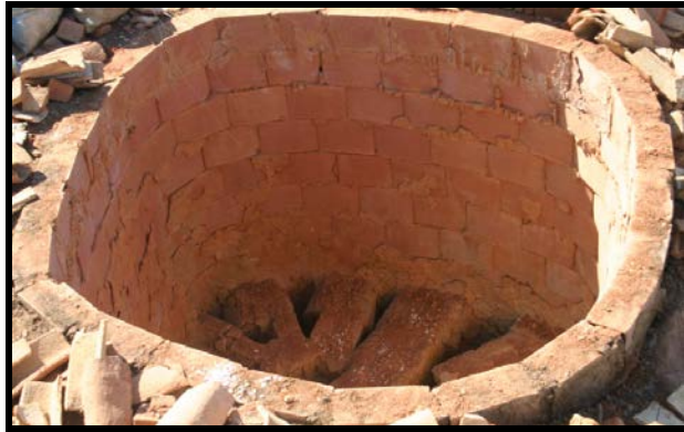
Photo 3.37 : La chambre de cuisson ne dispose pas de « Beb Echerioule »
