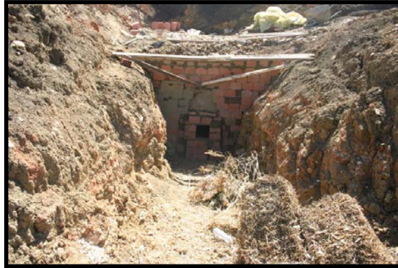
Photo 3.21 : La chambre des combustibles « El Koucha » (Source : D.T : le propriétaire de la filière.)
