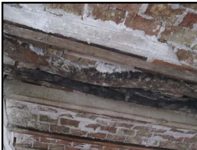
Photo 4.4 : Vue du plancher.
