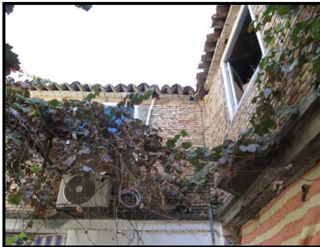
Photo 4.8 : Cloisonnements, fermetures d'une partie d'une partie de la galerie.
