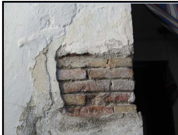
Photo 4.20 : Fissuration très avancée et décollement de l'enduit du mur intérieur.
