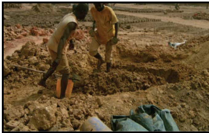
Photo 3.7 : Hydratation et malaxage de la terre
