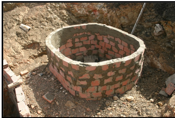
Photo 3.22 : La chambre de cuisson « Echerioul » (Source : D.T : le propriétaire de la filière.)
