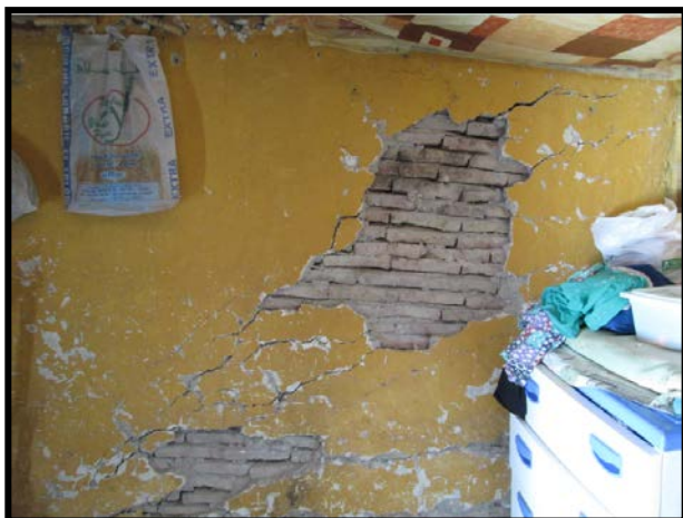
Photo 4.20 : Fissuration très avancée et décollement de l'enduit du mur intérieur.
