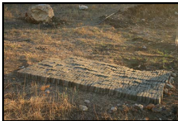
Photo 3.15 : Le deuxième cycle de séchage des briques
