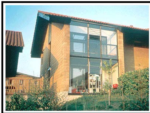
Photo 2.16 : Des maisons mitoyennes en blocs de terre vibro compactée et stabilisée.
