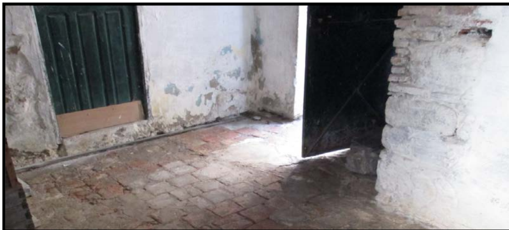
Photo 4.1 : RDC « Skiffa » le sous-bassement du mur est en pierre, en dessus en brique de terre cuite.
