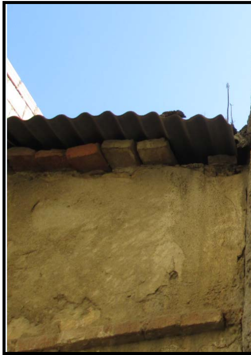
Photo 4.13 : Remplacement de la couverture en tuile par la tôle.
