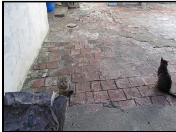
Photo 4.25 : L'arrachement des briques utilisées comme pavage du sol.
