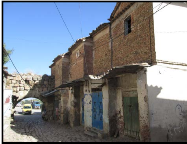
Photo 3.46 : Utilisation des briques cuites dans la réhabilitation d'une maison (Vieux Mila)
