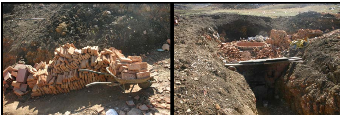
Photo 3.41 : Le déchargement des briques cuites après refroidissement
