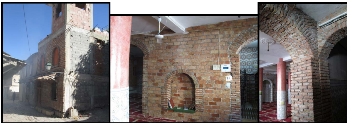
Photo 3.45 : Utilisation des briques cuites dans la construction de la mosquée de Mouhadjer Abou Dinar (Vieux Mila)
