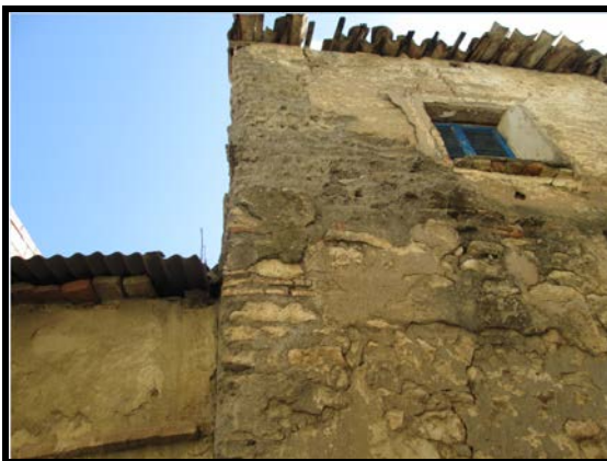
Photo 4.16 : Remplacement du toit en tuile de terre par la tôle ondulée.
