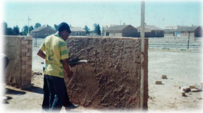
Photo 1.1 des élèves utilisant la terre pour s'exercer à enduire les murs
