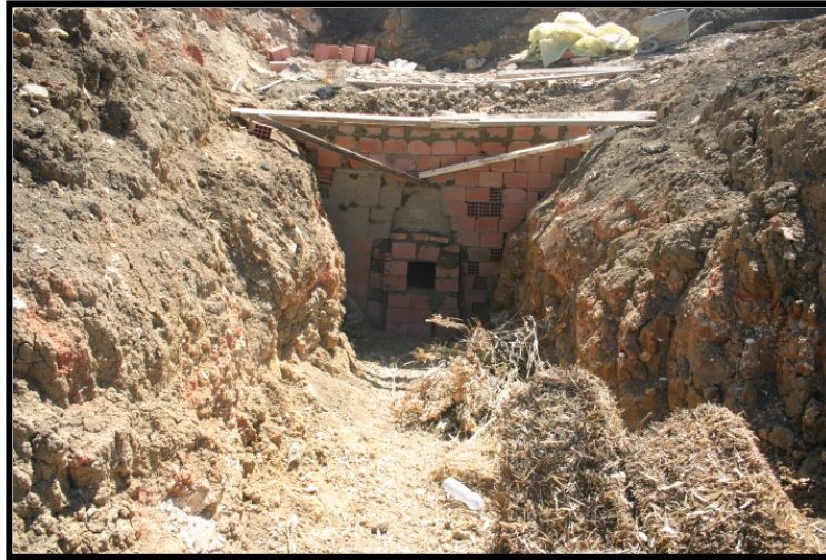
Photo 3.19 : La construction du four par des briques ordinaires (Source : D.T : le propriétaire de la filière.)
