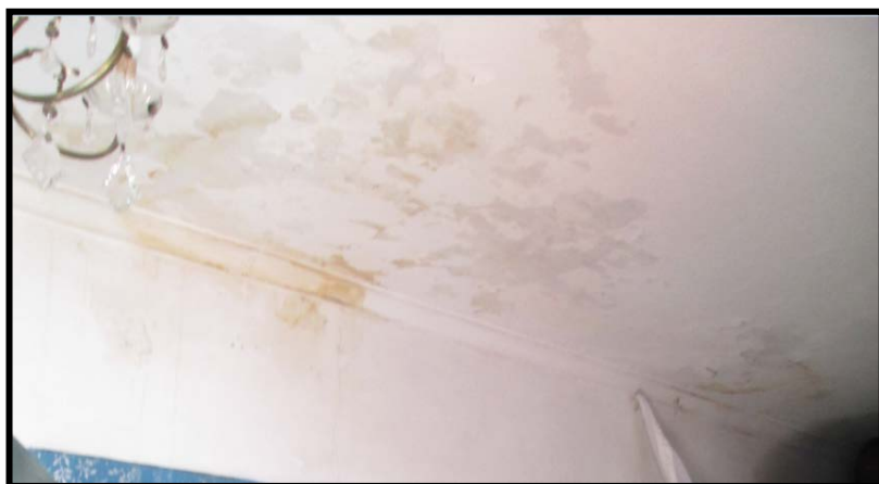
Photo 4.21 : Traces et tâches d'humidité visibles sur le plafond et le mur.
