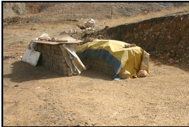
Photo 3.16 : Le stockage protégé des briques
