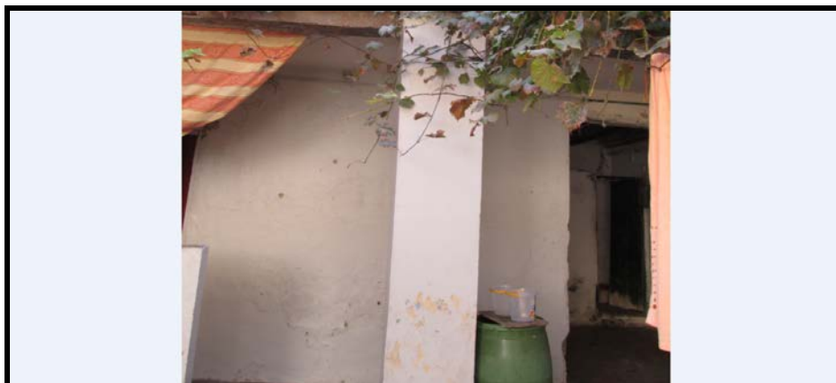
Photo 4.6 : Au RDC le mur en pierre est recouvert par un enduit à base de chaux.
