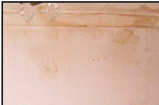
Photo 4.21 : Traces et tâches d'humidité visibles sur le plafond et le mur.
