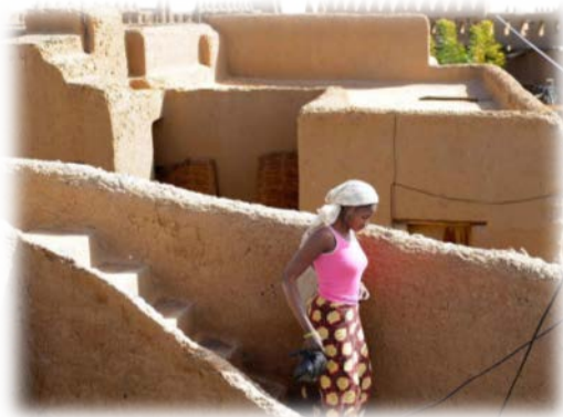
Photo 2.7 : Maison en pisé Djenné, Mali (Source : WHEAP, Inventaire de l'architecture de terre, Programme Du Patrimoine Mondial Pour L'architecture De Terre, 2012)
