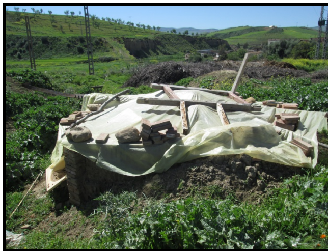
Photo 3.2 : Un four à Mila presque démolie
