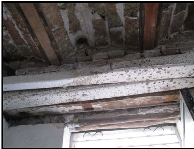
Photo 4.12 : Incorporation des poutres en acier.
