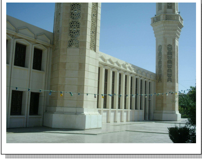
الشكل 7.5: صورة للواجهة الجنوبية لقاعة الصلاة. (المصدر: المكتب المصمم B.E.T.B)
