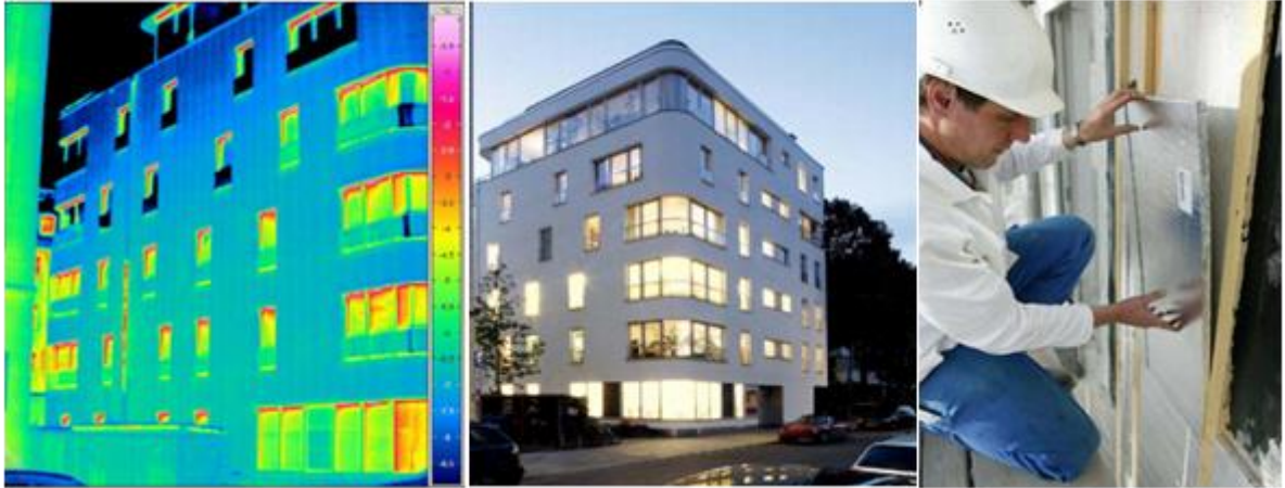
Figure 2.14 Thermographie d'une façade extérieure d'un bâtiment isolé thermiquement par un (VIP) en Seitzstrasse à München[68].
