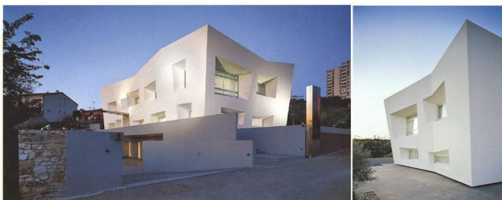
Figure 2.5 Revêtement en nanoparticule hydrophobe assurant la durabilité de la peinture blanche d'un bâtiment commercial en Croatie [68].
