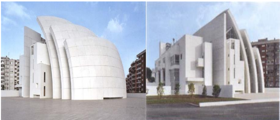
Figure 2.7 Revêtement photocatalytique en ciment blanc composé avec des nanoparticules de marbre et dioxyde de titane préservant l'aspect de l'enveloppe de l'église Dio Padre Misericordioso [68].
