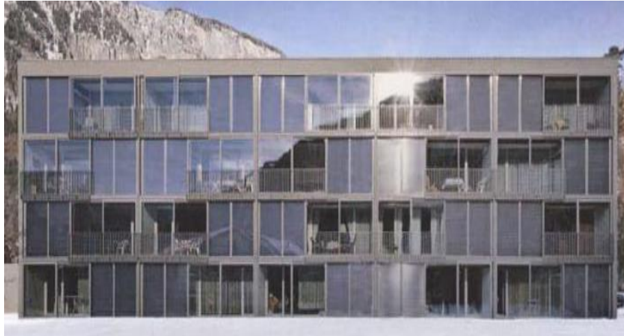
Figure 2.11 Façade d'une maison pour personnes âgées à Falveng en Suisse GLASS Crystal [68].
