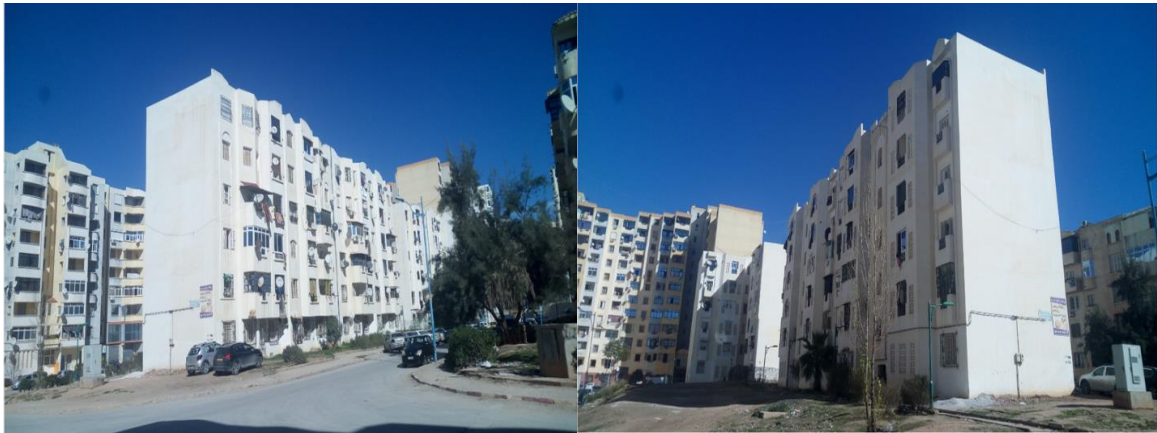
Figure 5.10 Façade principale et postérieure du logement en structure conventionnelle depuis l'axe principale et le parking.
