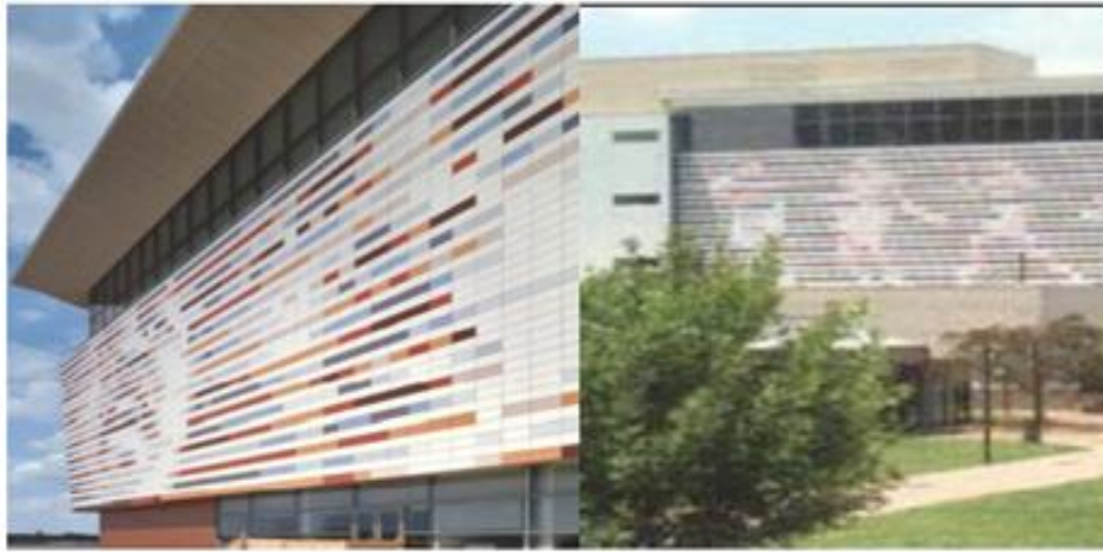
Figure 2.6 Revêtement en carreaux de céramiques assurant la durabilité de la façade photocatalytique d'un centre Ali MAC en USA [68].
