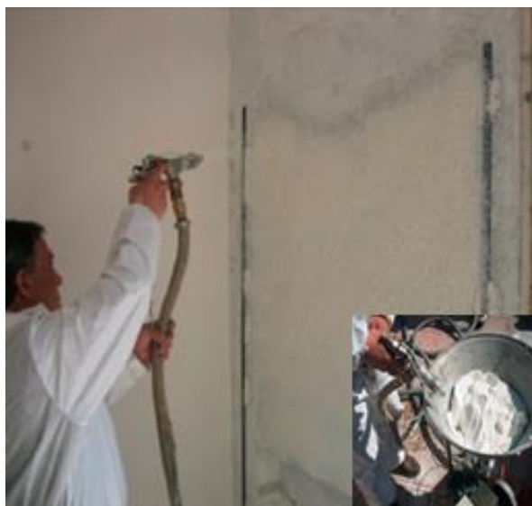
Figure 2.17 Application in situ du plâtre à base d'aérogel [93].
