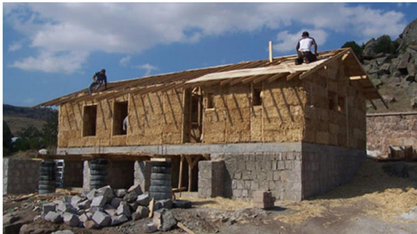
Figure 1.12 Balles de paille constituant le mur de remplissage de l'écocentre de Kerkenes [32].
