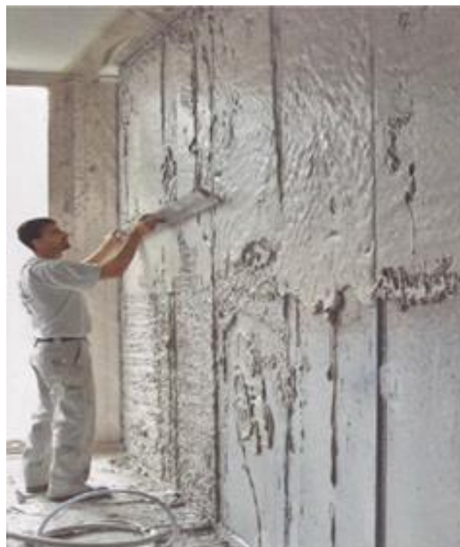
Figure 2.21 Application in situ du plâtre à base d'aérogel [68].
