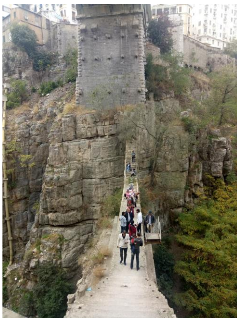
Figure 7.20 Manque de rampe d'escalier sur le pont romain- Constantine.
