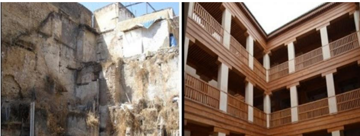
Figure 4.10 Intérieur avant et après réhabilitation du Foundouk Chemmaine. Medina de Fès.
