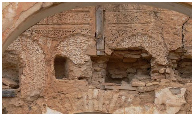
Figure 5.11. Le fragment en stuc découvert en 1989 lors des travaux de démolitions. Source l'office national de gestion et d'exploration des biens culturels à Tlemcen
