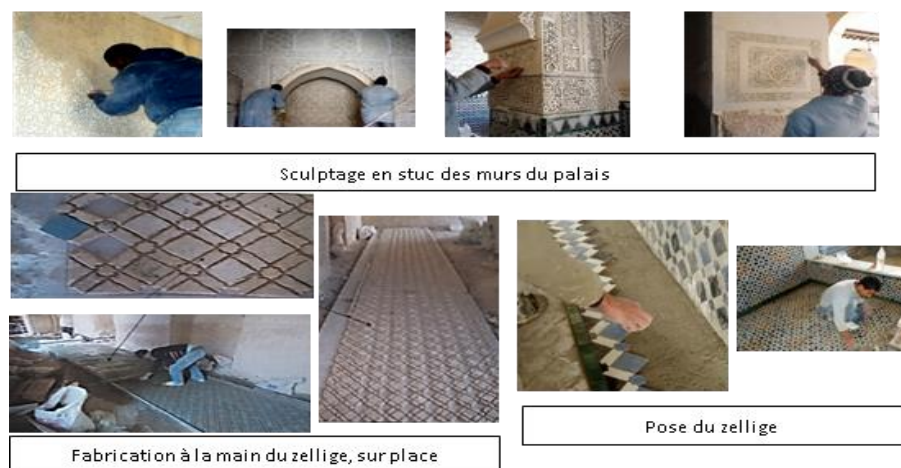
Figure 6.9. Travaux de restauration des ornements (en 2010). Source : direction de la culture - Tlemcen
